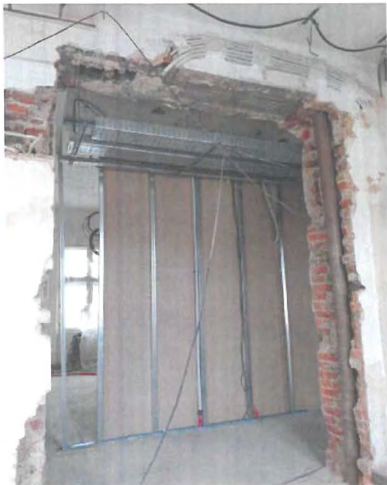
13a zalomení chodby v 4np
