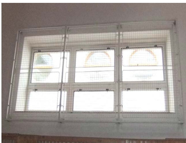
- okna a ochranná síť v tělocvičně
