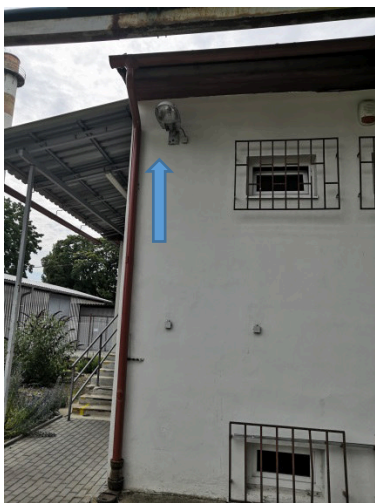
8. Oprava osvětlení – výbojkové lampy 3 kusy na plášti SO č. 040 oprava (výměna) výbojkových světel.
