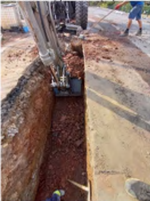
Obr. 4 – fragmentace výkopku
