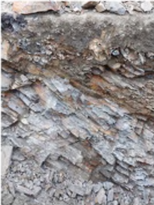
Obr.8 – použití kladiva v polohách slabě navětralých drob (tř.6).
