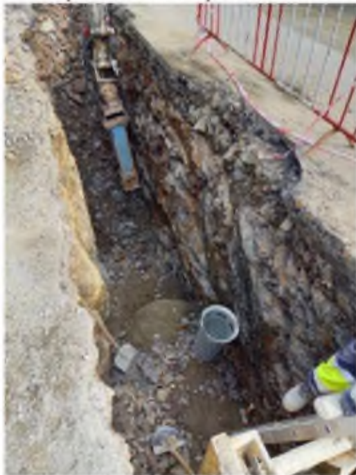
Obr.8 – použití kladiva v polohách slabě navětralých drob (tř.6).
