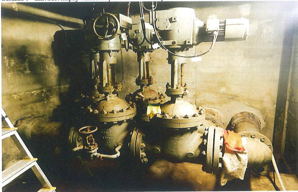
Obrázek 2 - extrémní vnitřní koroze potrubí a pevná překážka mezi přírubami ventilů do vsakovacího pole
