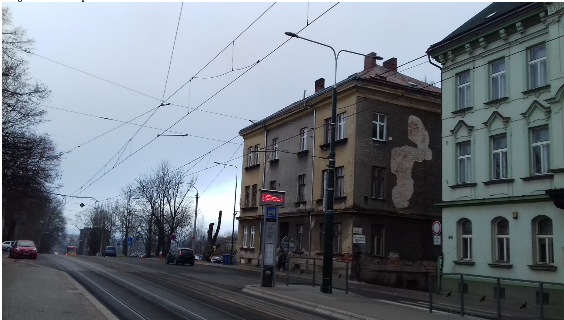
Fotografie dotčeného prostoru č. 1
