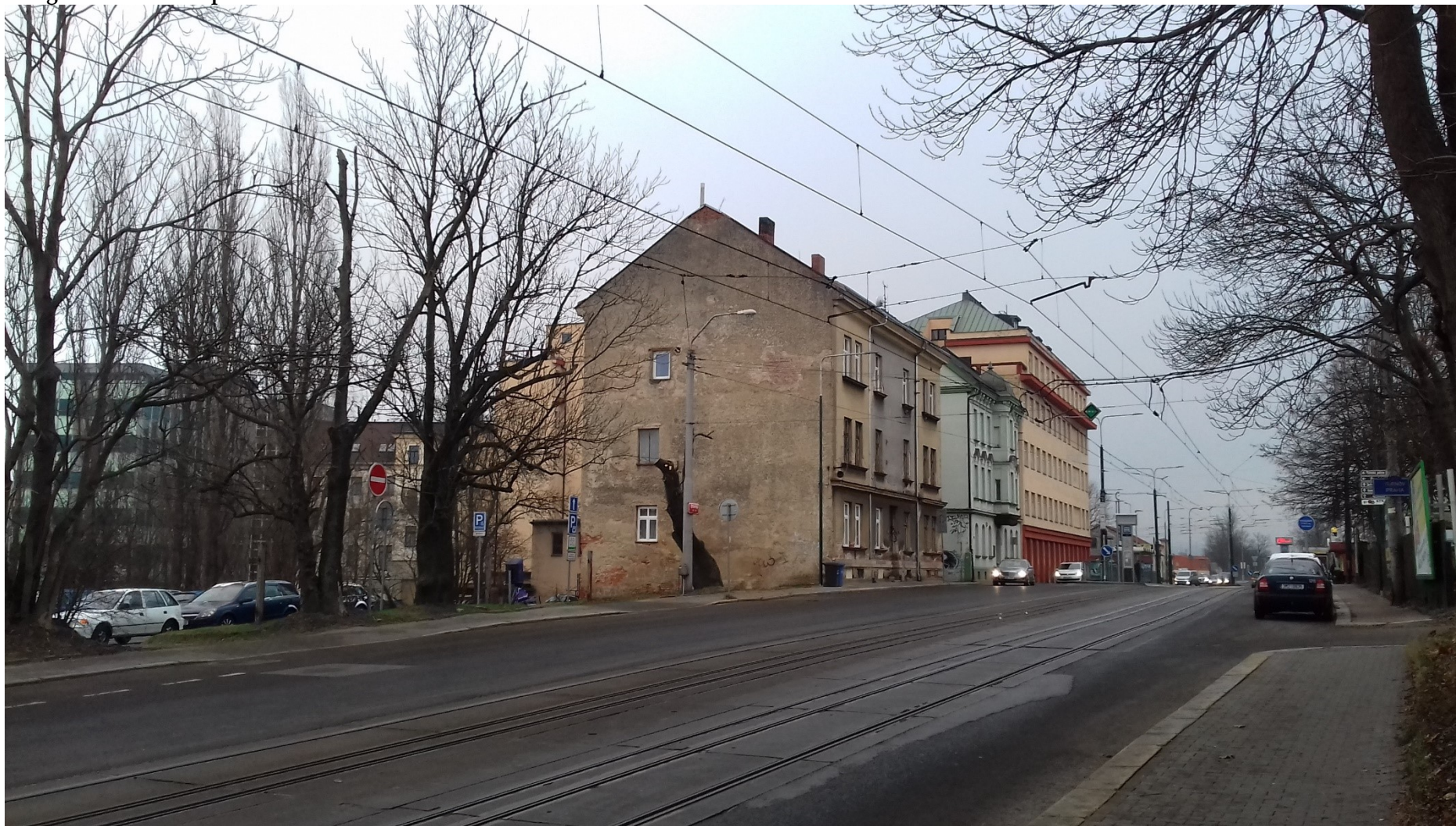
Fotografie dotčeného prostoru č. 2
