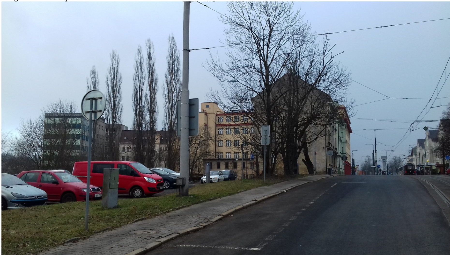
Fotografie dotčeného prostoru č. 3
