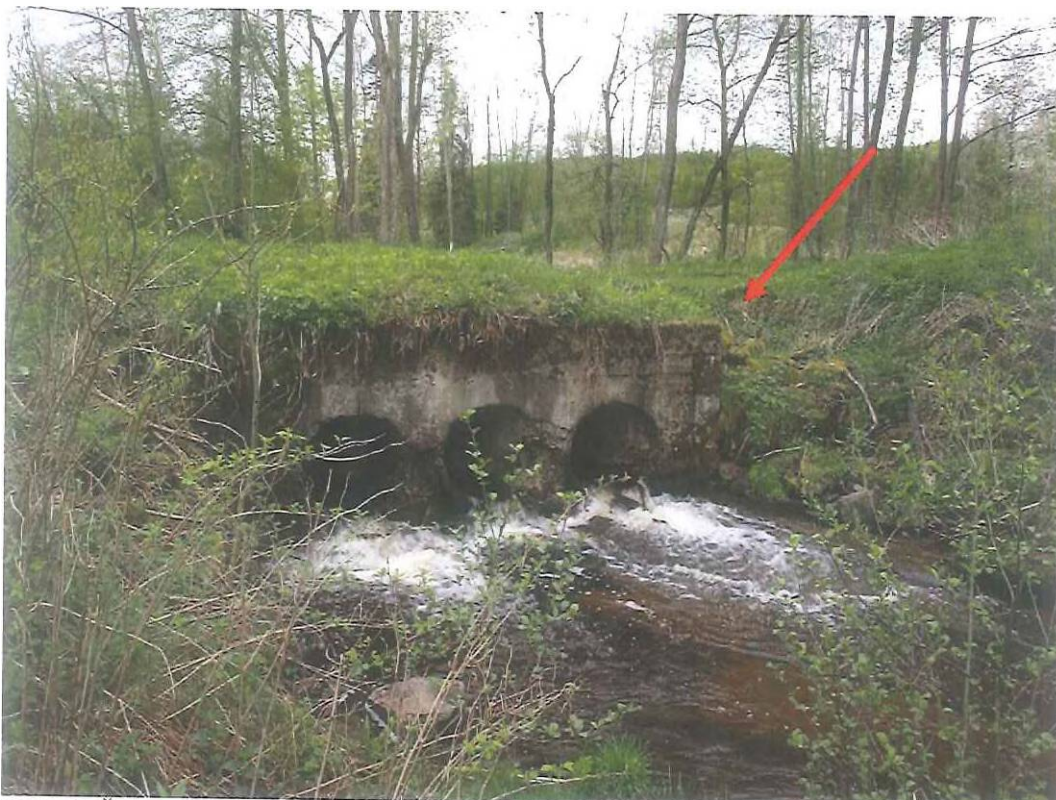
Foto 2 Čelo propustky – pohled proti toku. Snížená část je vyznačena šipkou.
