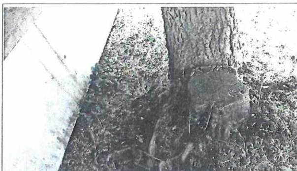
Obr. 3 – Detail báze kmene u opěrné zdi.
