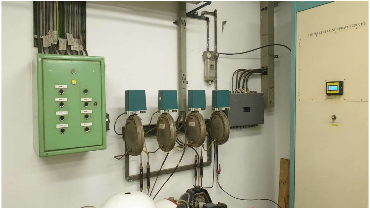
Obr. 2 Nasávací objekt – pneumatické ovládání 30 let starých ventilátorů
