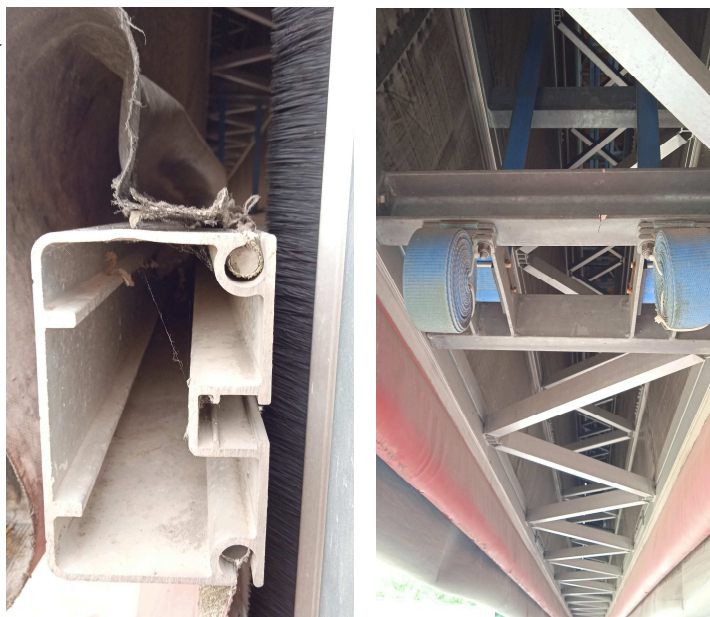
Detail uchycení plachtového panelu a příhradníkového nosníku
