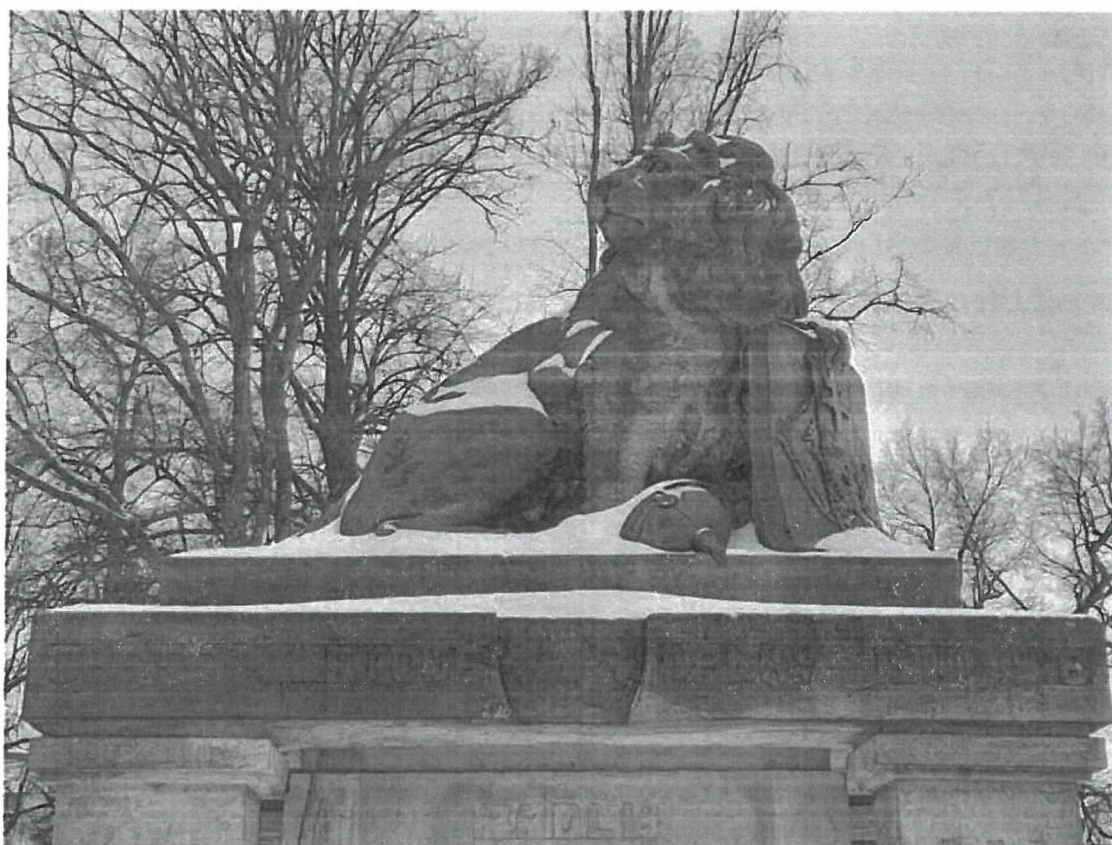
Obr. 1 / Vrcholové partie pokryté znečišťujícími depozity a povlaky řas. Chybí středový erb, v jeho okolí je hornina mechanicky poškozena. Opatření: vyčistit povrch, doplnit defekty, doplnit erb, konzervovat povrch.
