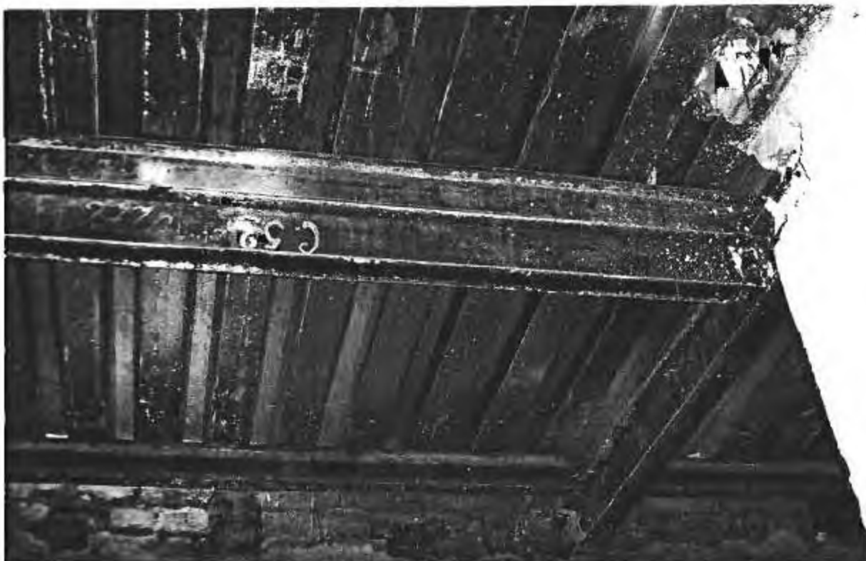
Použití původních ocelových prvků
