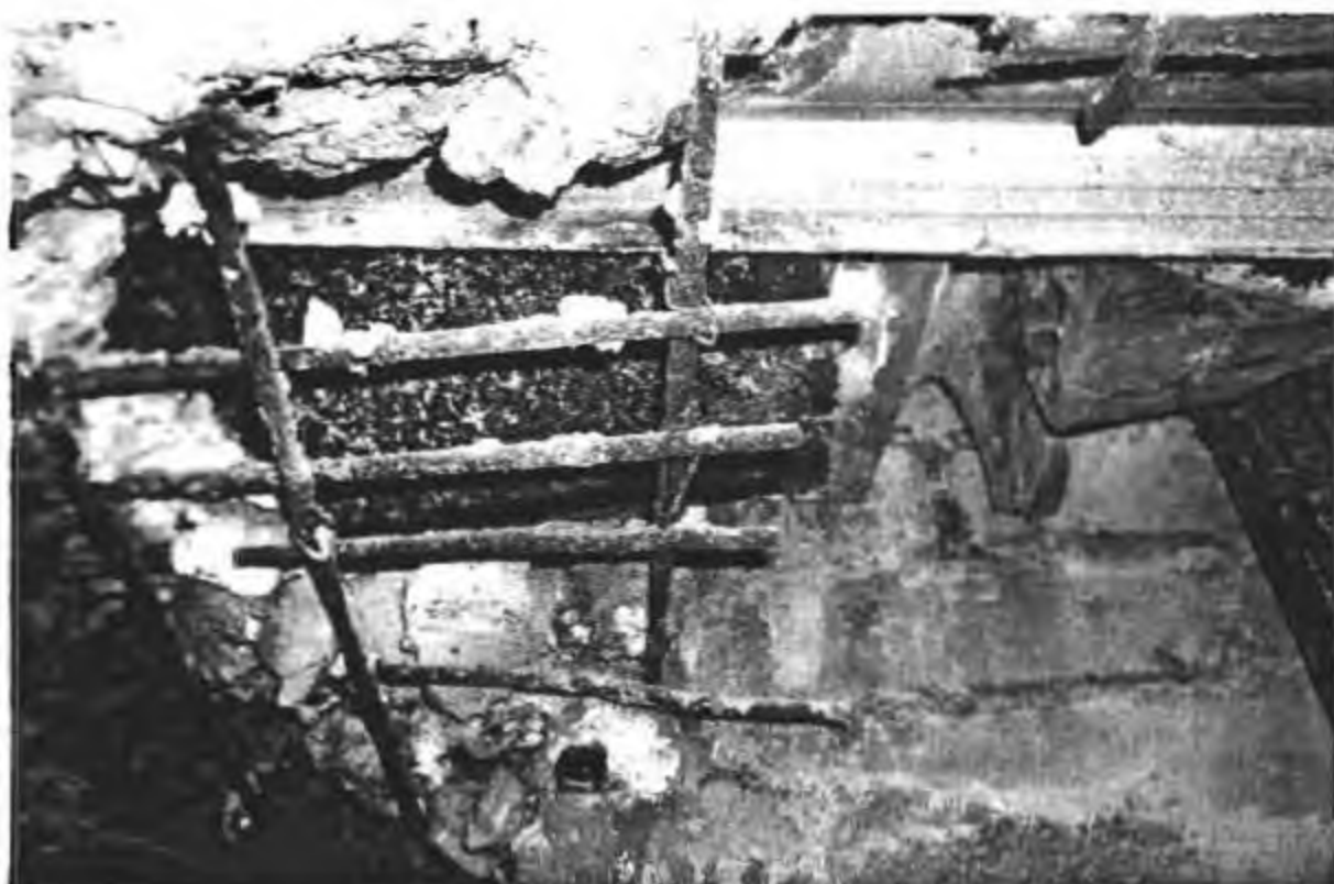
Celková kvalita stropní konstrukce
