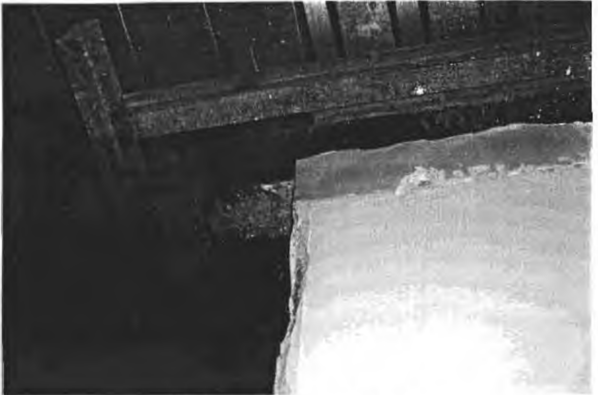
Způsob podepření ocelové konstrukce
