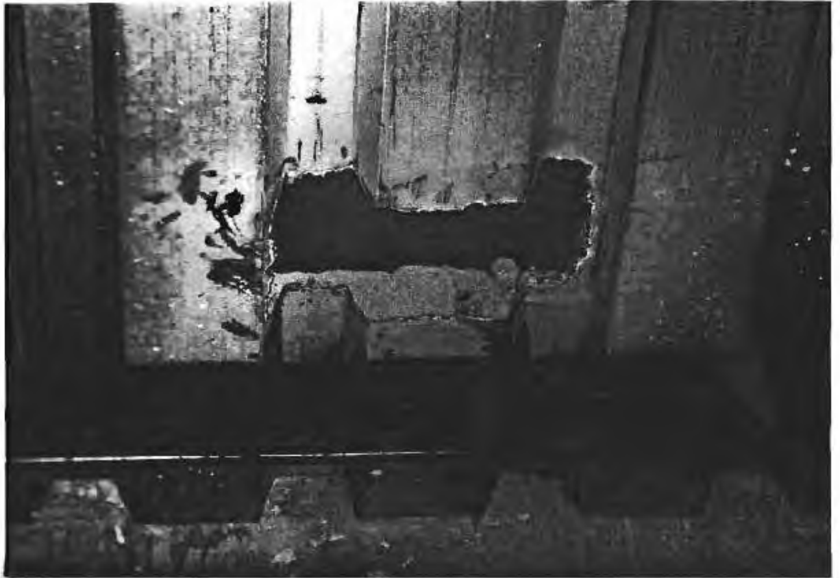
Tloušťka betonové vrstvy nad trapézovým plechem
