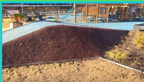
Ukázka realizace na nerovném terénu a svazích....
