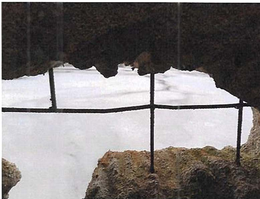
5) Pohled do otvoru v čelní stěně požeráku
