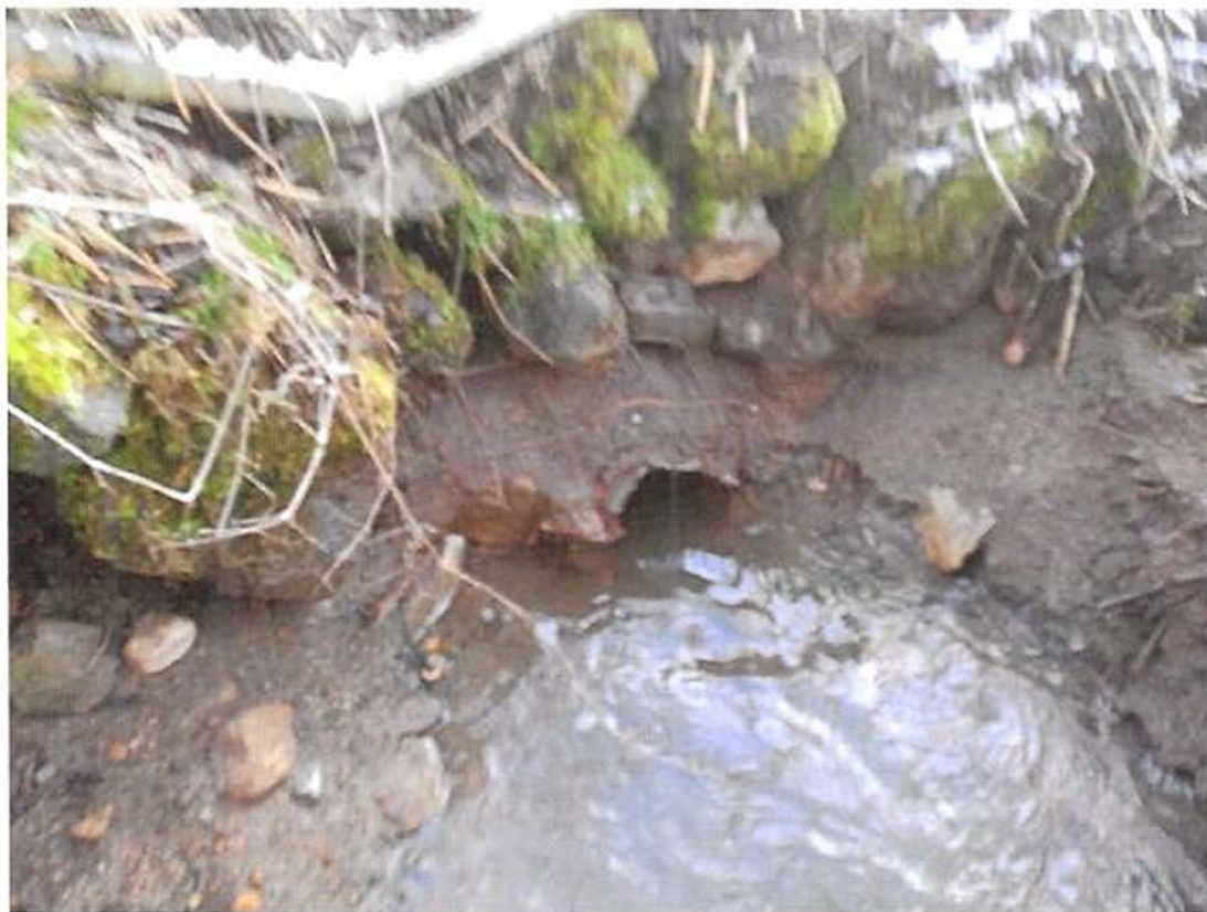
9) Pohled na výtok odpadního potrubí
