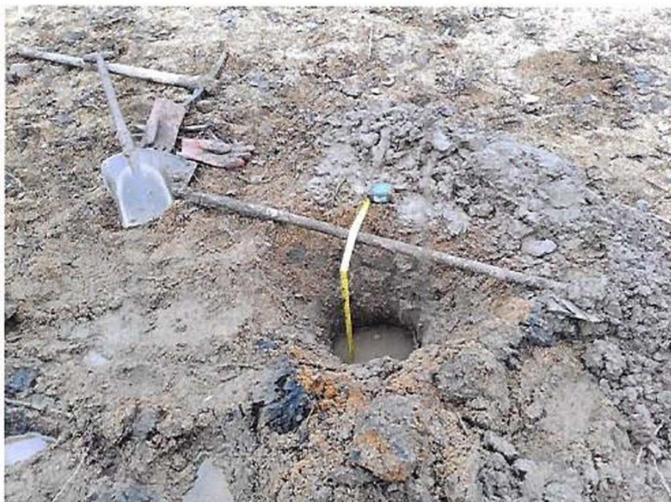
Sonda č. 5 u hráze u pravého zavázání
