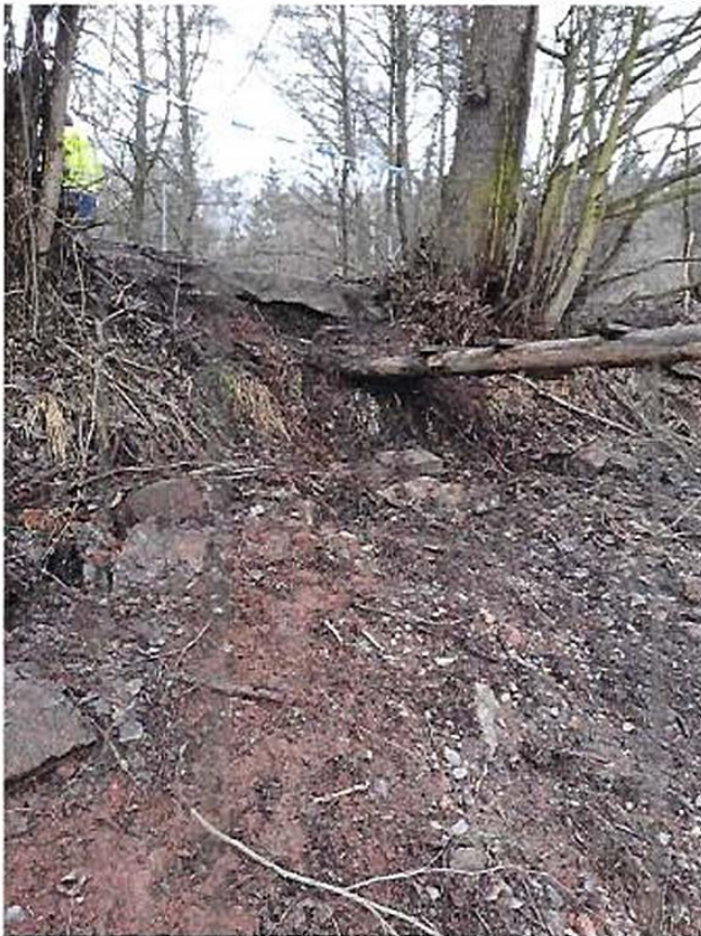
13) Pohled na návodní líc hráze nesourodě složení materiálu černé skládky
