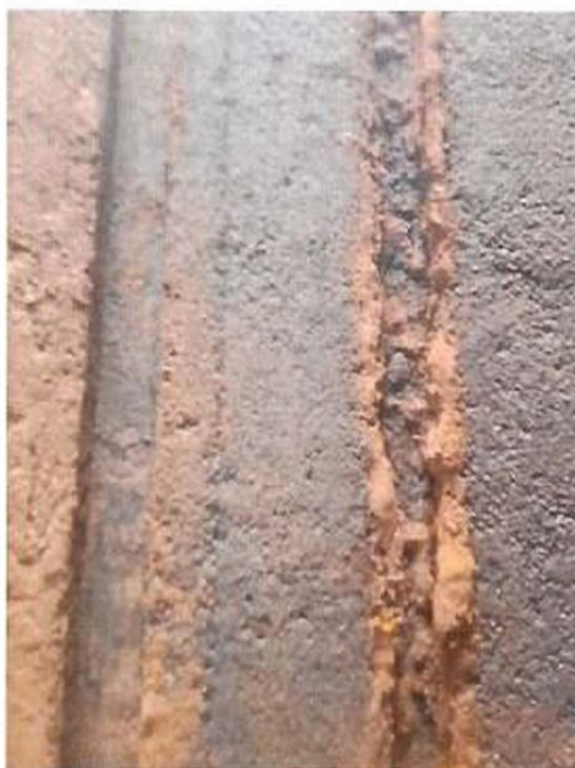
6) Pohled na dlužové drážky
