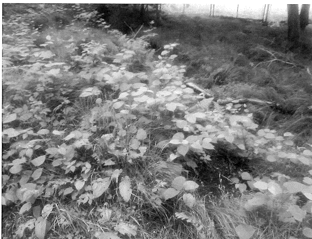
Překopaná cesta, pod nánosy zeminy je penetrace
