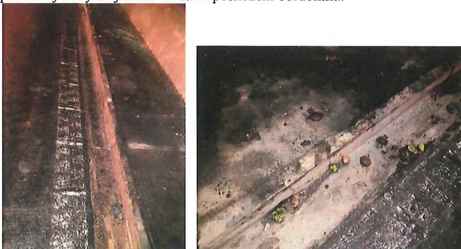
Fotodokumentace stavu obrubníku a štěrbinového žlabu
