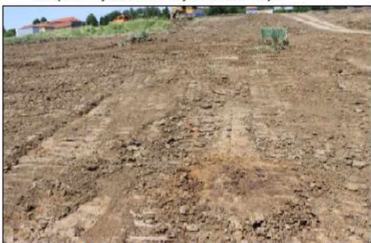
Obr. 1 - Stav zjištěných objektů po skrývce
