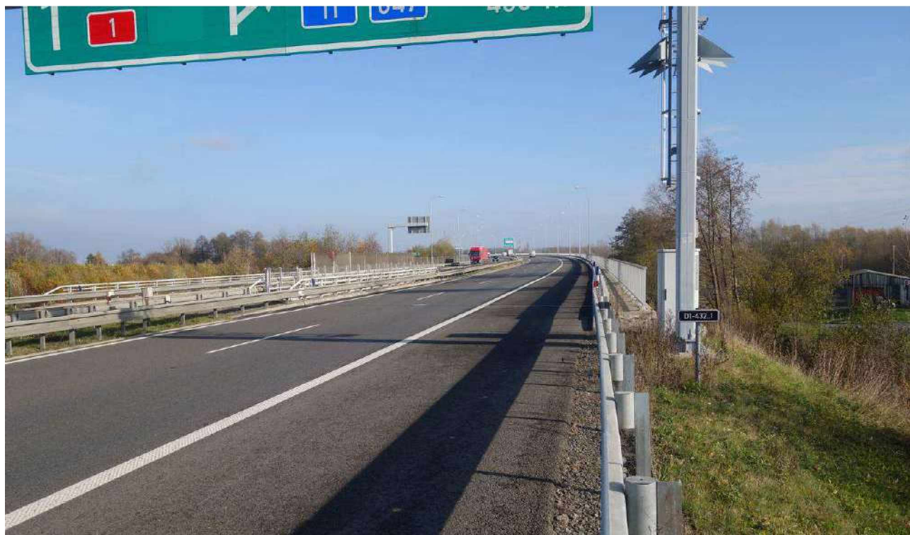
Most ev.č. D1 – 432..1
