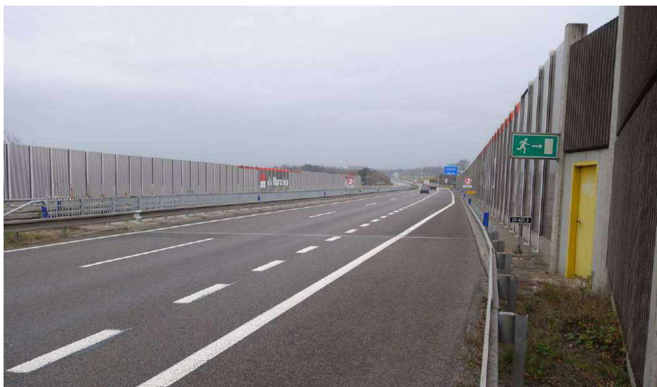
Most ev.č. D1 – 427..2
