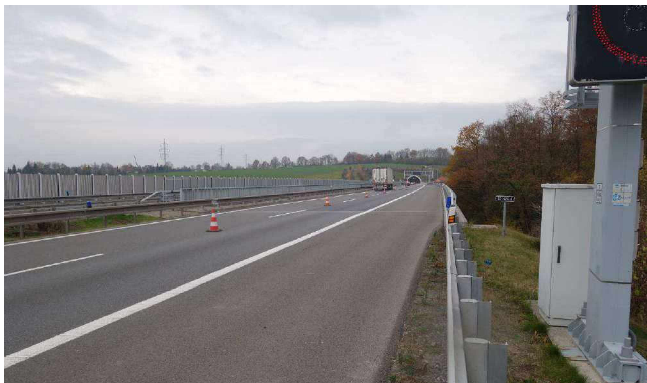
Most ev.č. D1 – 424..2
