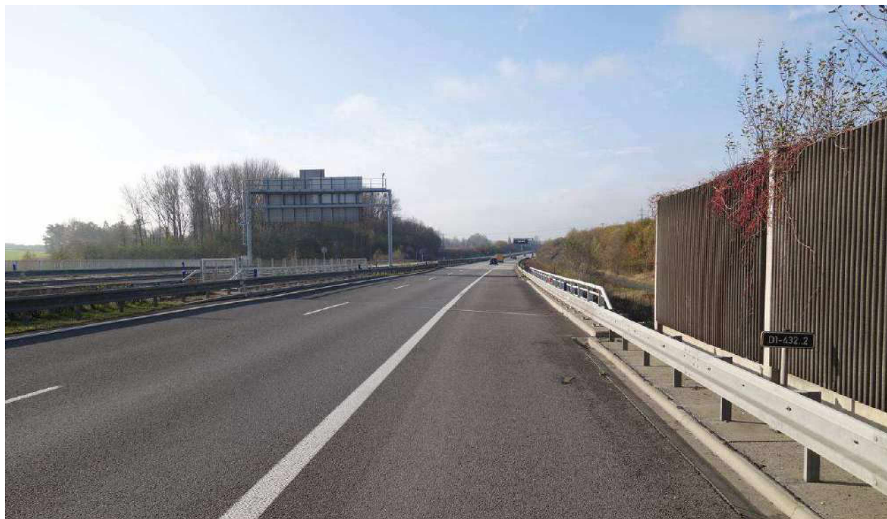
Most ev.č. D1 – 432..2
