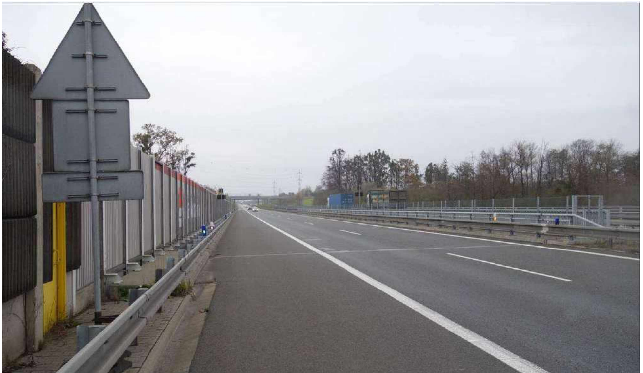
Most ev.č. D1 – 422..1
