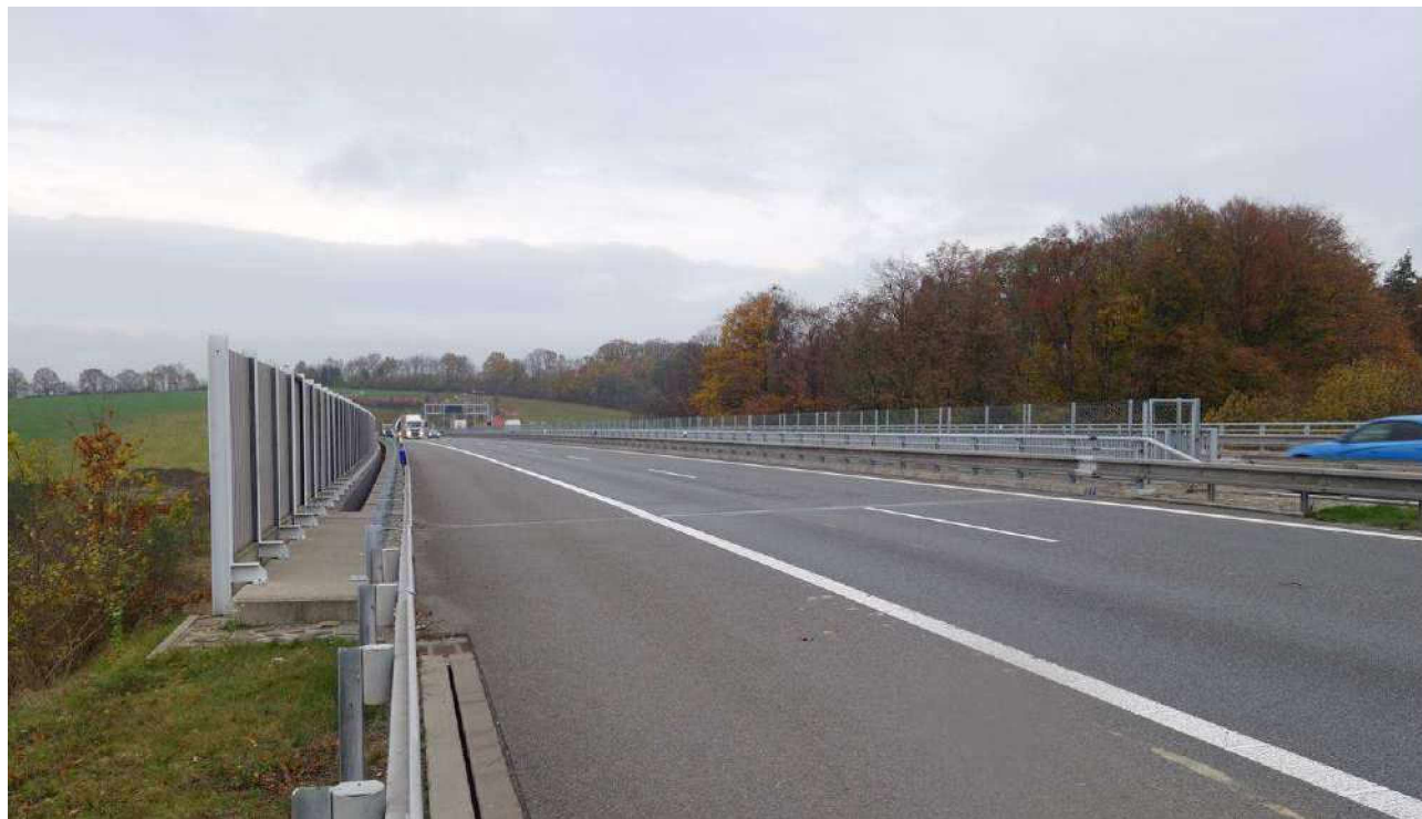
Most ev.č. D1 – 424..1
