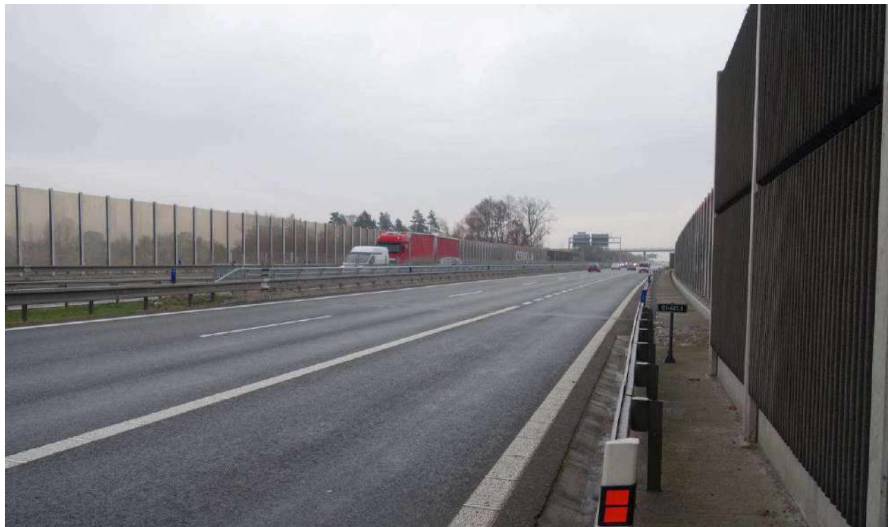
Most ev.č. D1 – 427..1
