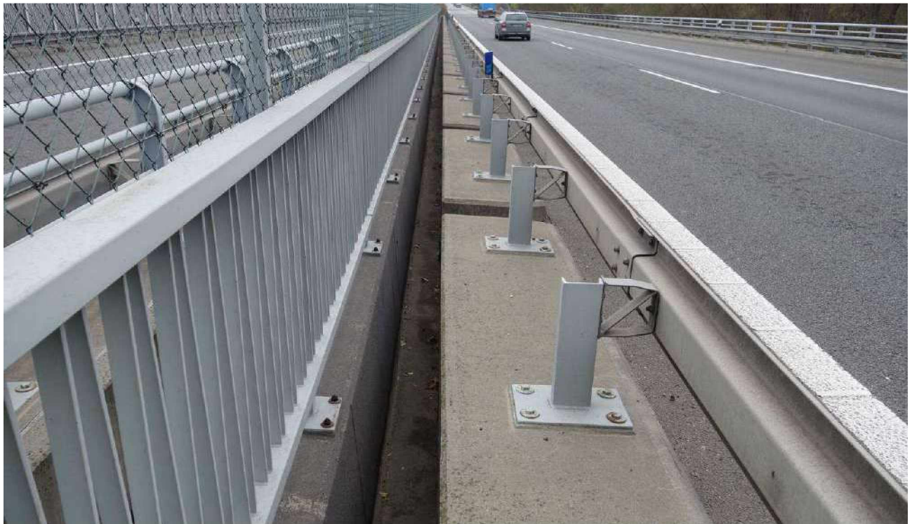
Most ev.č. D1 – 422..2
