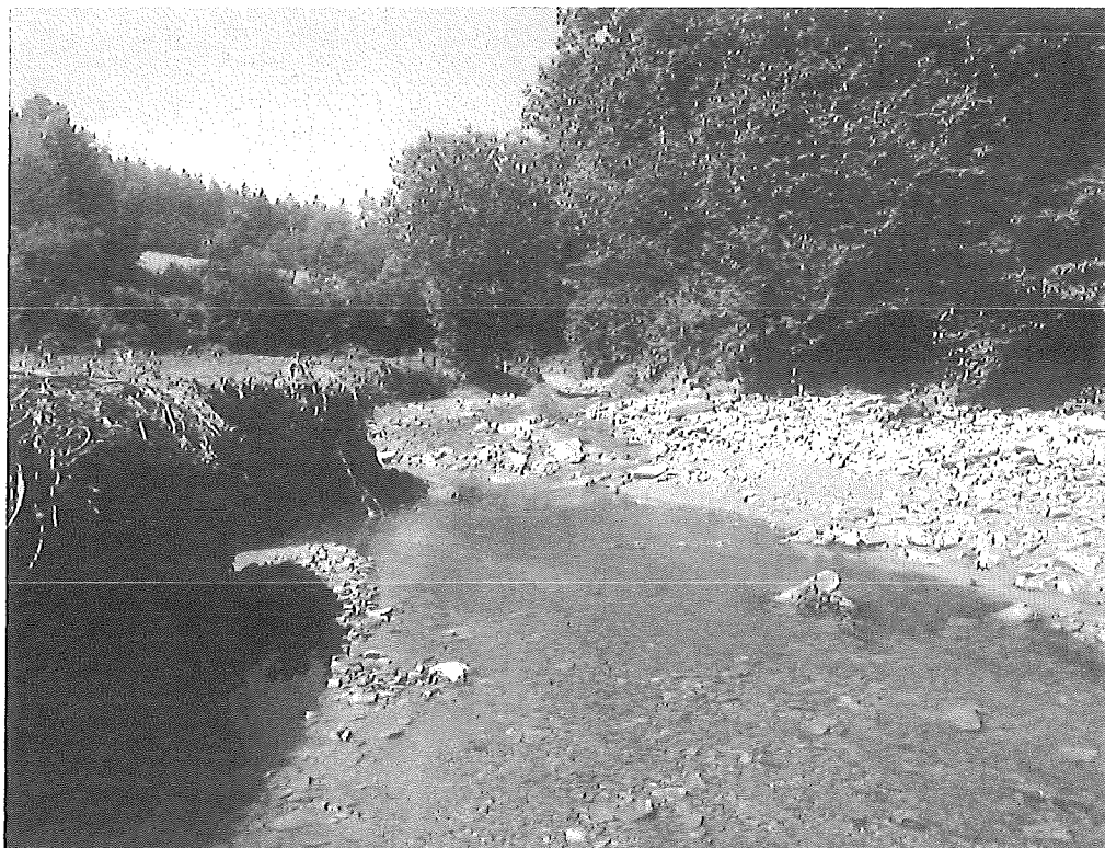
Prohloubení koryta nad obcí Bílsko po opakovaných povodních v roce 2019
