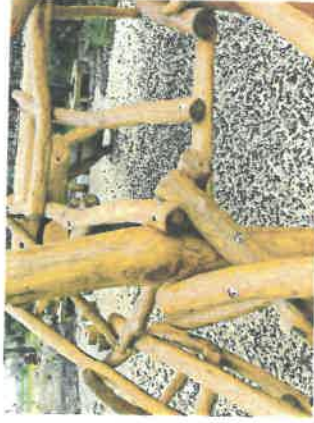
Kotvení ke stromům pomocí dřevěných podkladků
