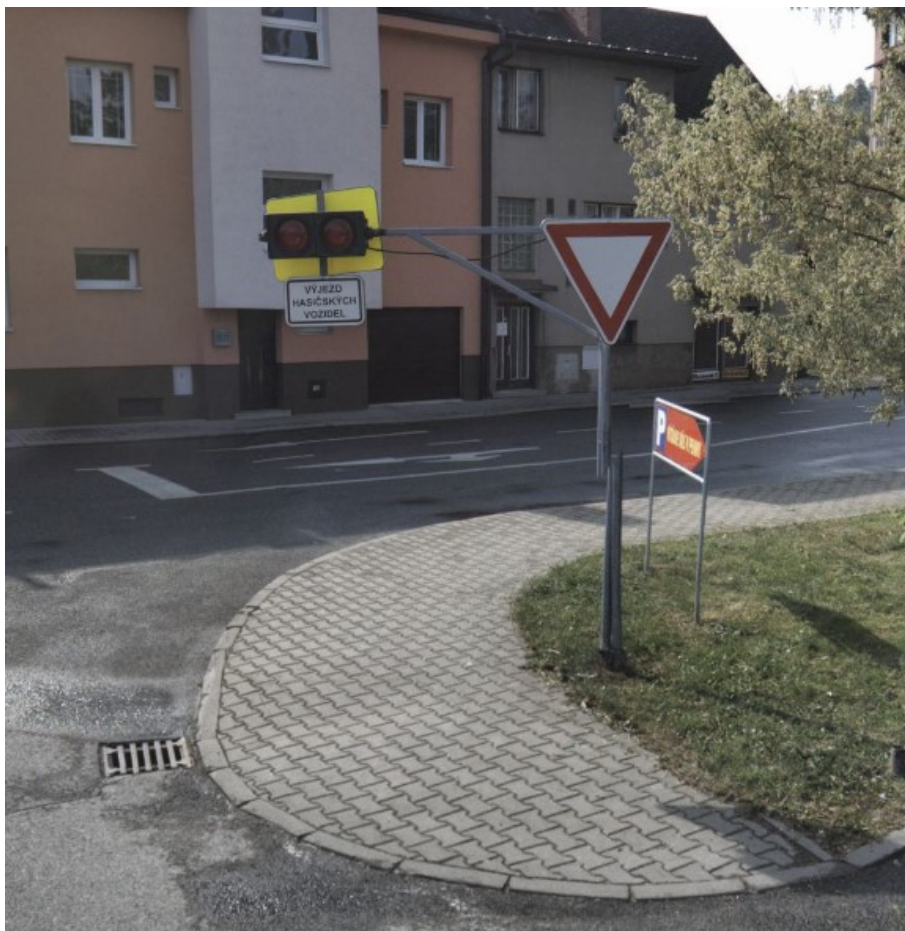
Semafor 3 - Původní stav
