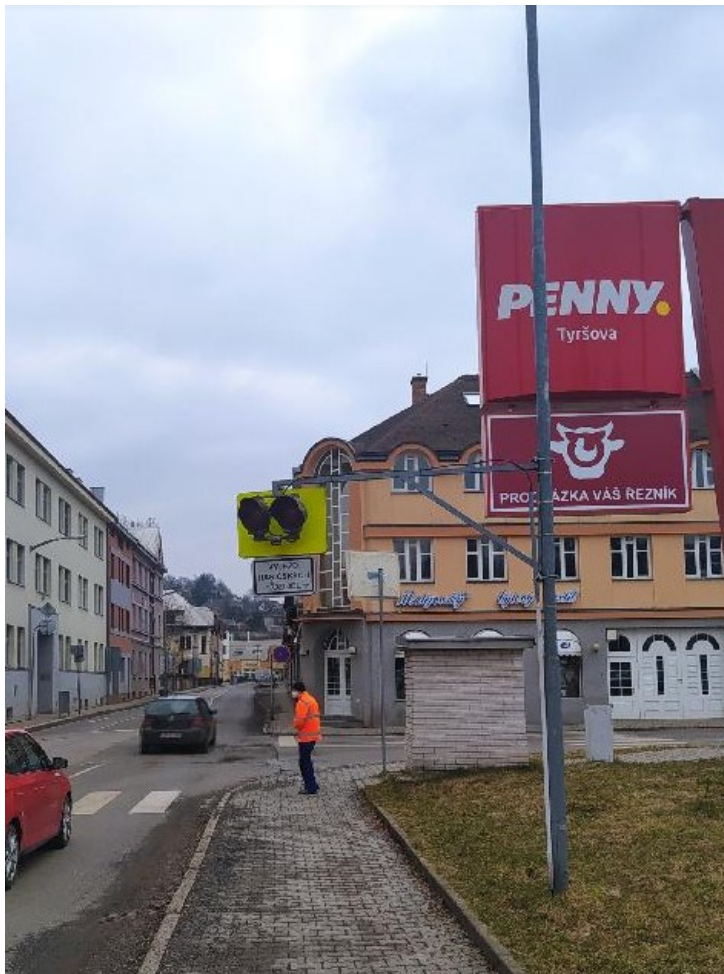
Semafor 2 - Původní stav
