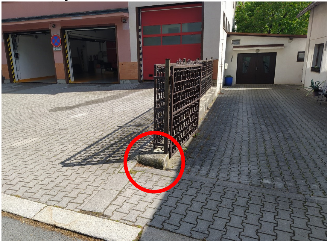
Semafor 4 - Původní stav
