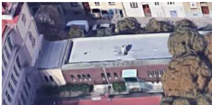
Obr. č. 4 Letecký pohled na objekt gastroprovozu ze dvora (zdroj: www.google.cz )
