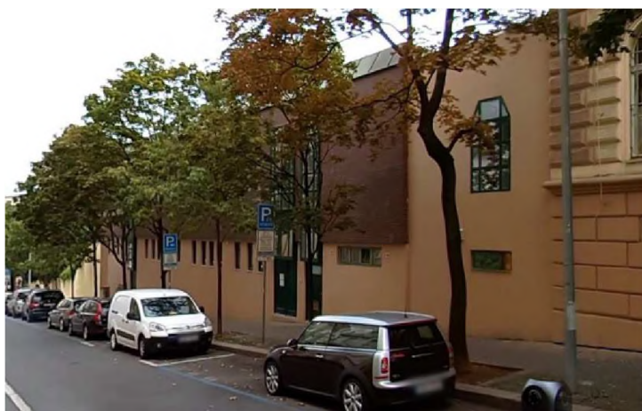
Obr. č. 2 Pohled na objekt gastroprovozu z ulice Kostelní (zdroj: www.google.cz )
