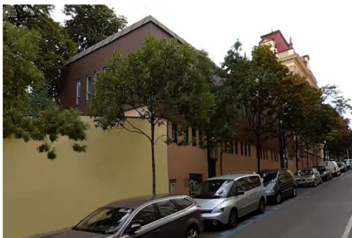
Obr. č. 3 Pohled na objekt gastroprovozu z ulice Kostelní (zdroj: www.google.cz )
