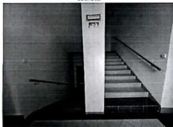
schodiště administrativní budovy
