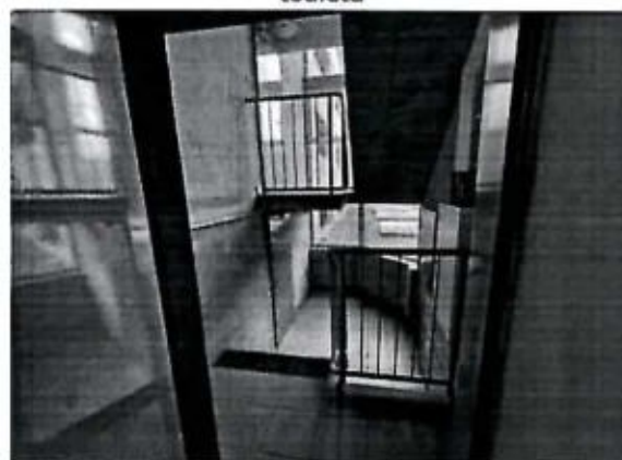
schodiště garážového domu
