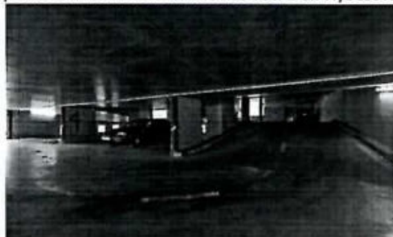
interiér garážového domu
