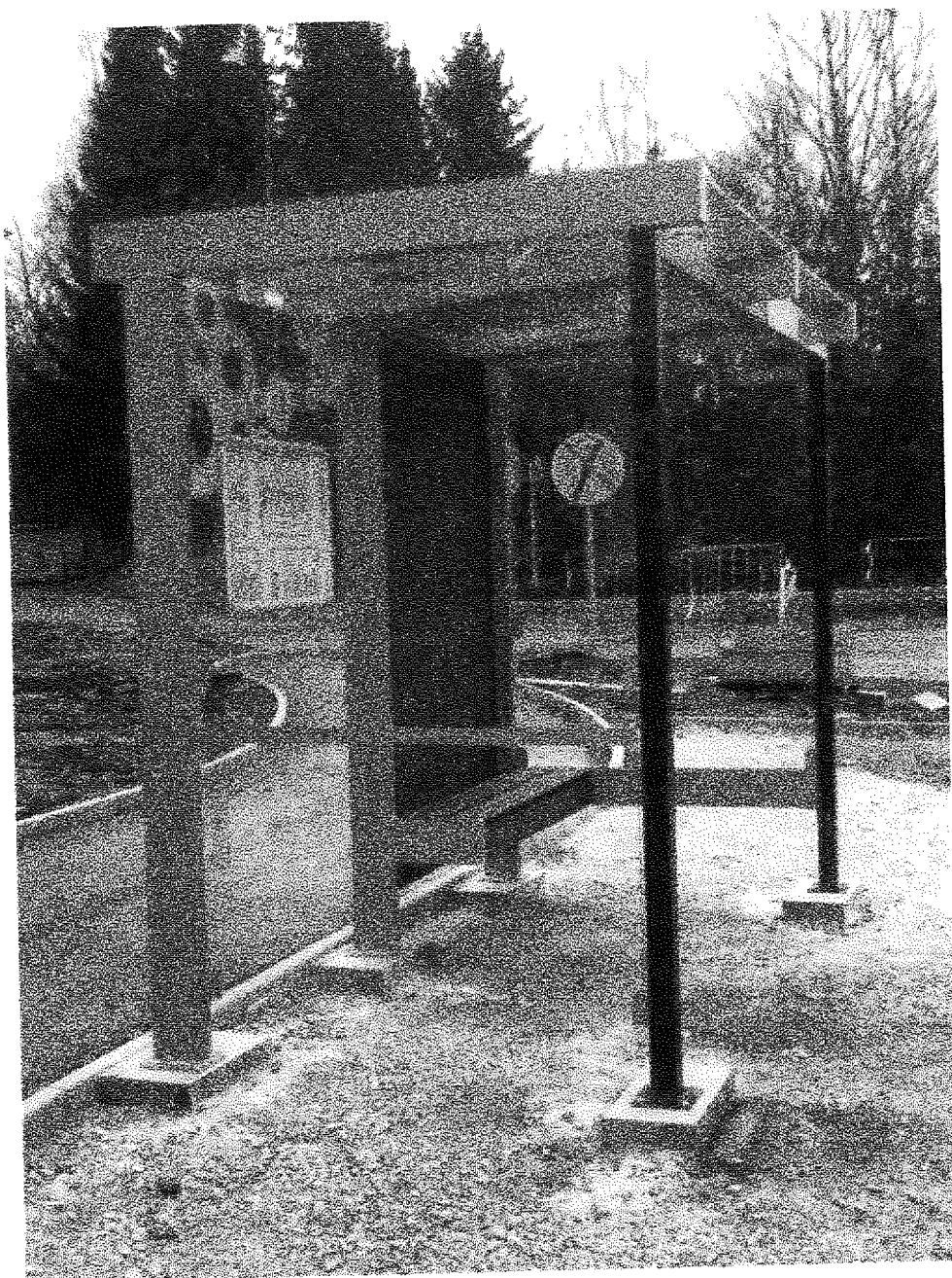
Realizace přístřešku AZC 2M
