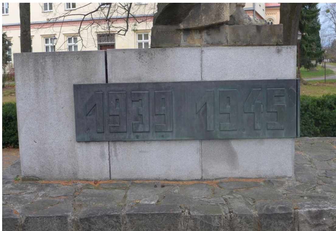
Současný stav Viditelné znečištění pískovcové sochy, bronzové desky pokryté měděnkou a tmavou krustou
