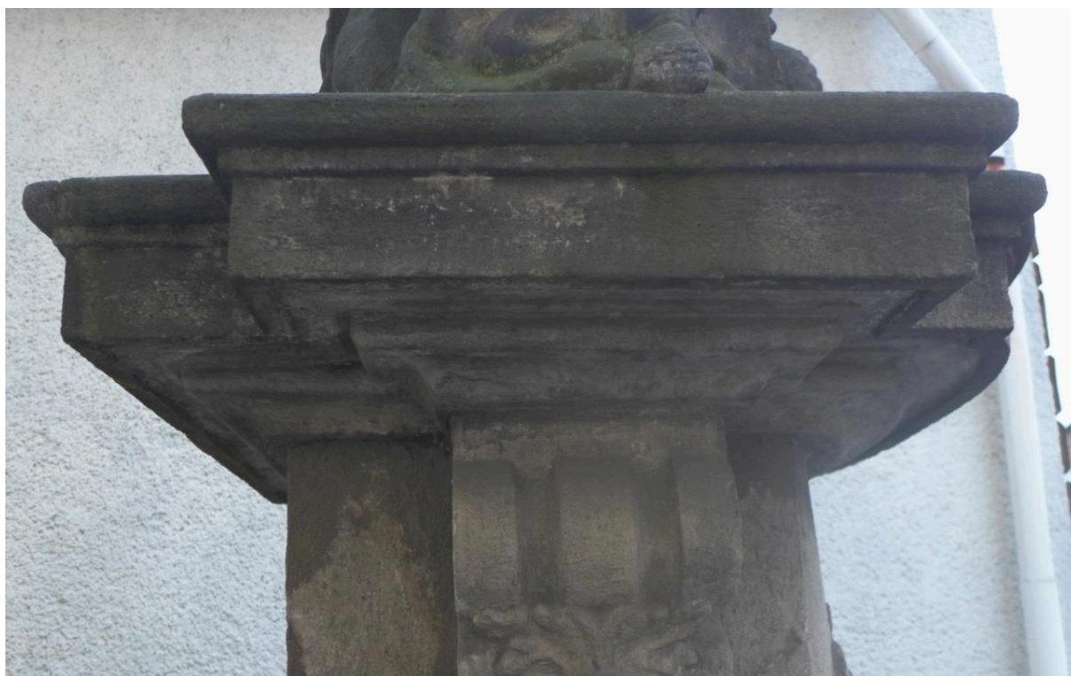
Současný stav Silné znečištění vrcholové sochy, svatozář druhotná, dole silné krusty v podhledech profilace římsy
