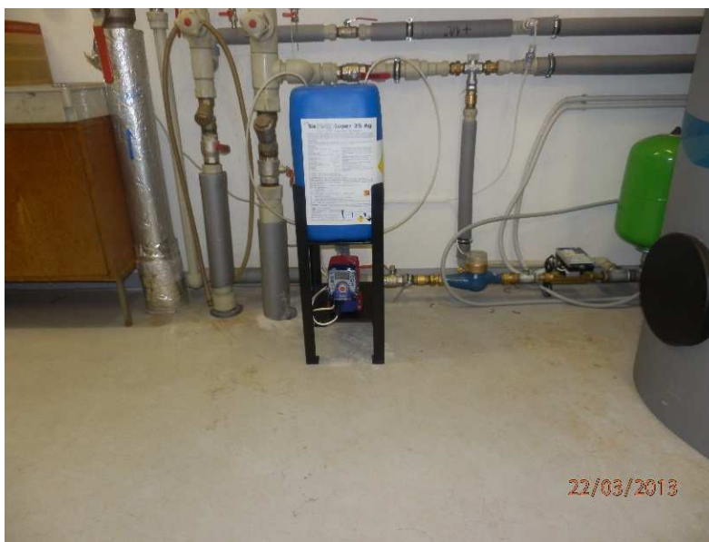
Obr. Příklad instalace souboru AQUA-TUV 1SA
