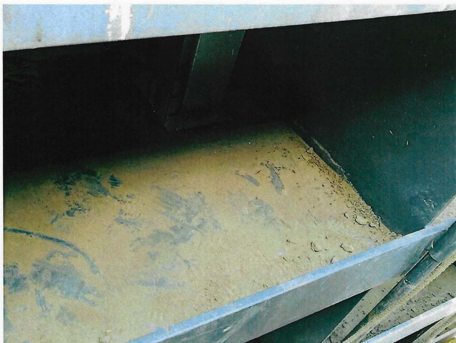
Pohled do konstrukce vrat na okno průchodu slupice hlavním vodorovným žebrem.
