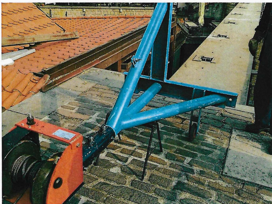
Detail základu jeřábku s navijákem.
