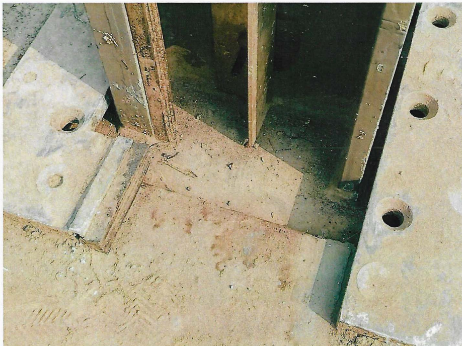
Pohled na kapsu s vytaženou slupicí na koruně vrat.
