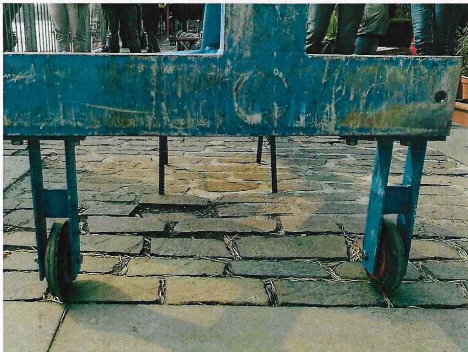
Pohled na spodní stranu základu jeřábku.
