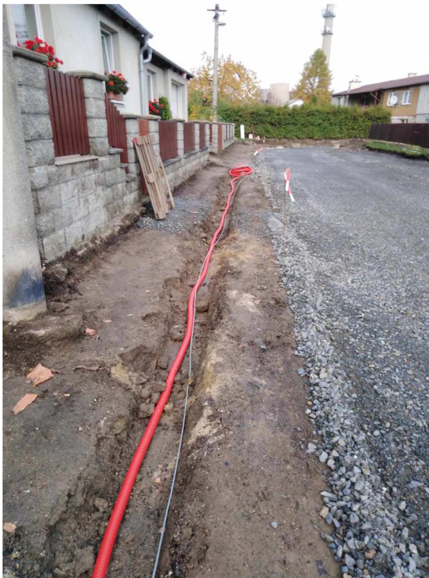
Obr. č. 1 – výkop rýhy pro chráničku budoucího veřejného osvětlení
