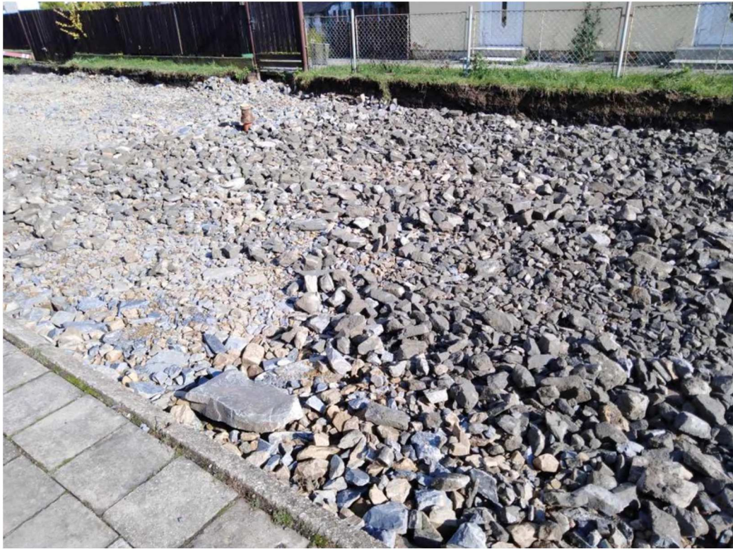
Obr. č. 2 – sanace lomovým kamenem
