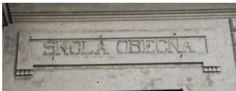
Nápis na severním průčelí západního křídla
