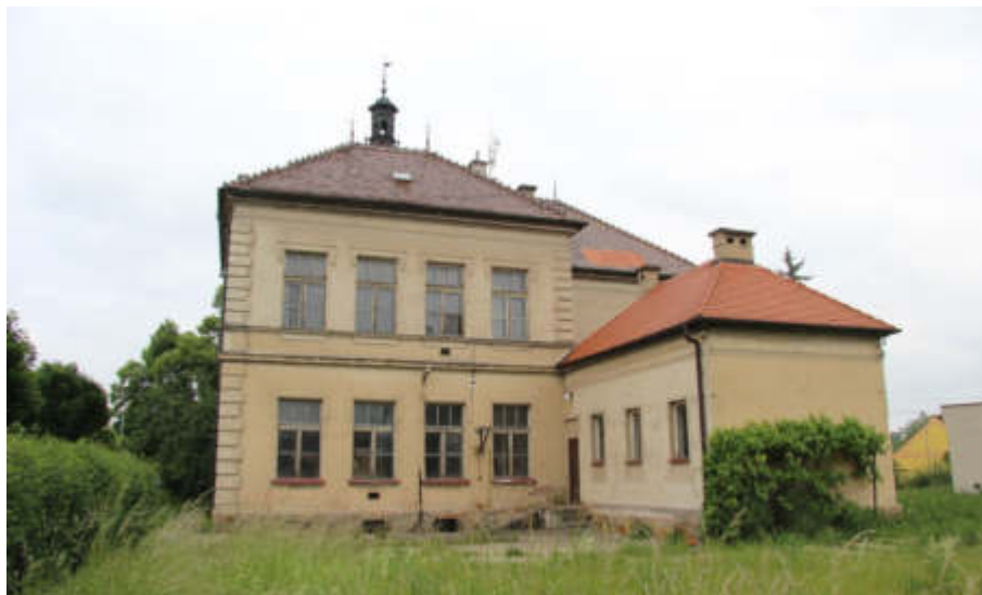
Celkový pohled od jihu
