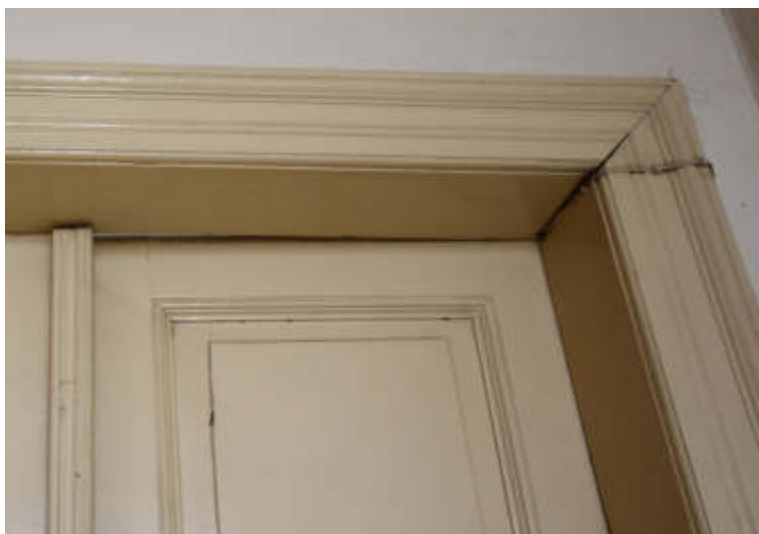
Detail profilace obložkové zárubně
