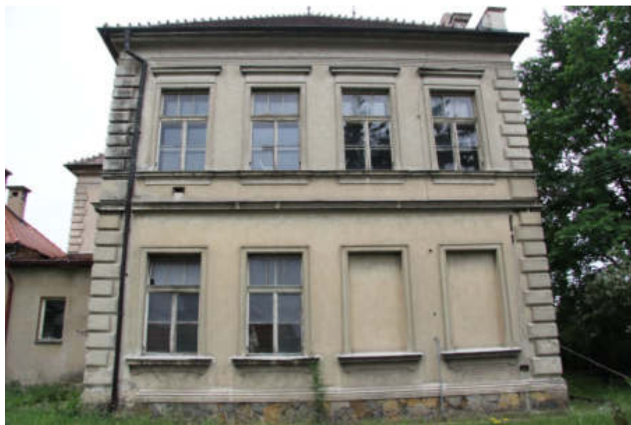
Východ. průčelí východ. křídla
