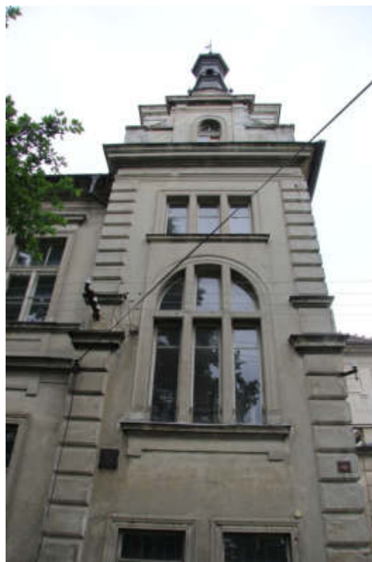
Severní průčelí východního křídla
