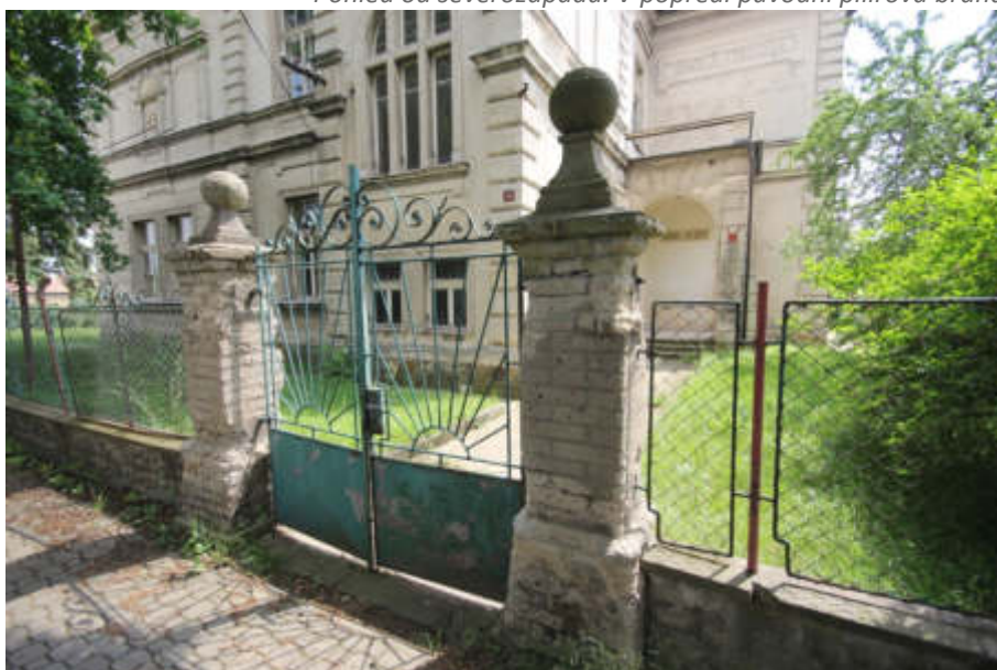
Detail piliřové brány na severní straně oplocení
