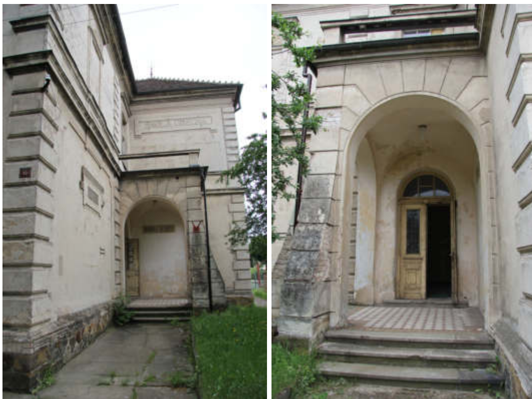
Portikus při pohledu od severu a při pohledu od západu
