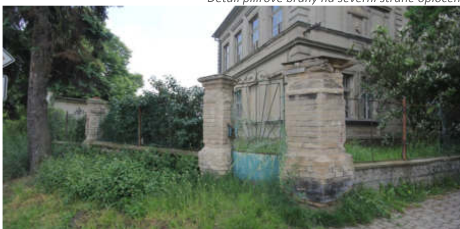
Pohled od severovýchodu na původní piliřový plot s brankou v nároží
