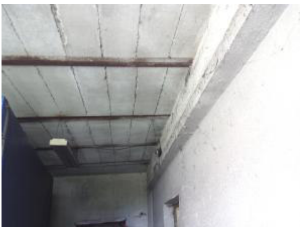
Pohled do přízemí (1.NP) objektu „Garáž“ 21.06. 2016
