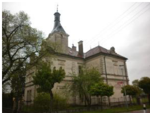
Pohled na objekt „Obecná škola“ od západu 04.05. 2016
