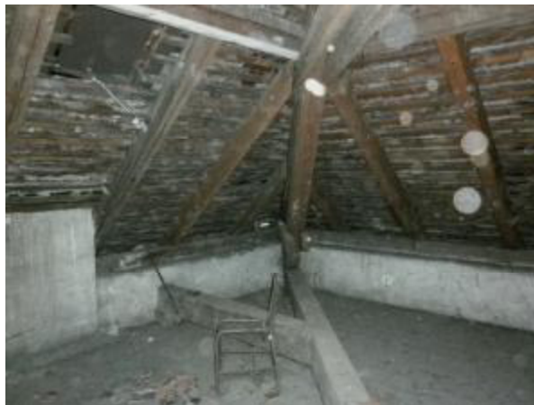
Pohled do krovového systému objektu (3.NP) 04.05. 2016
