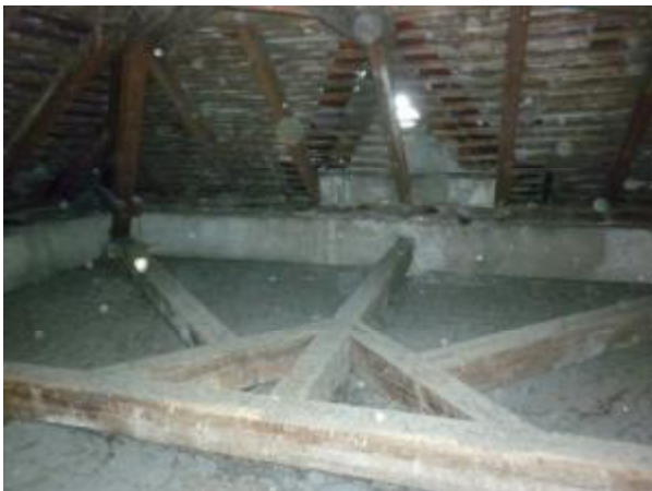
Pohled do krovového systému objektu (3.NP) 04.05. 2016
