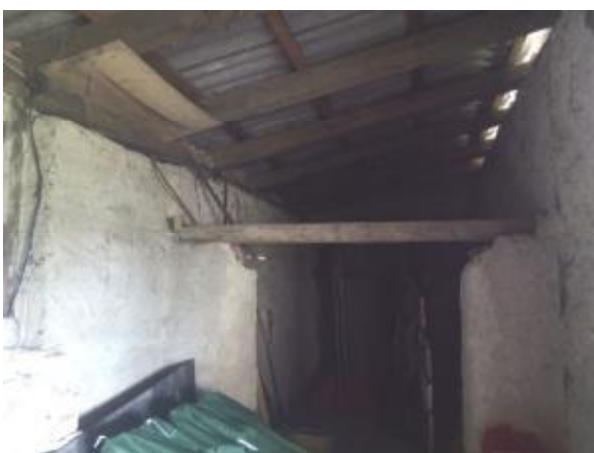
Pohled do přízemí (1.NP) objektu „Sklad“ 21.06. 2016
