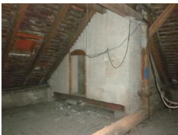
Pohled do krovového systému objektu (3.NP) 04.05. 2016
