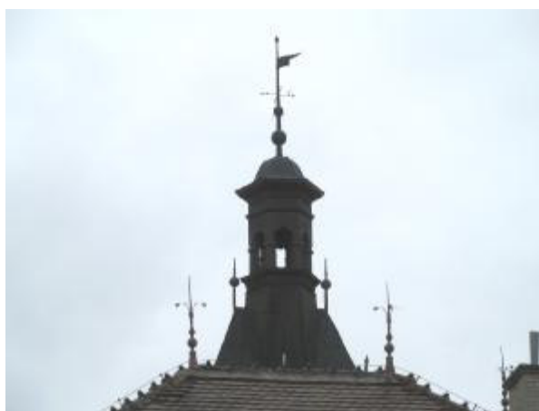
Pohled na „Věž“ objektu „Obecná škola“ 21.06. 2016
