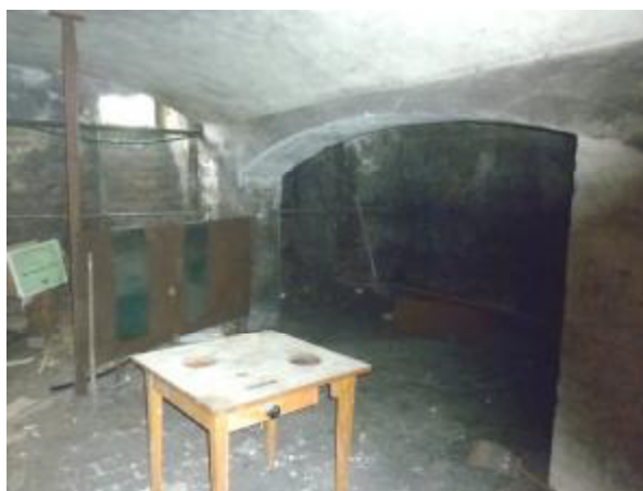
Pohled do suterénu zájmového objektu (1.PP) 04.05. 2016
