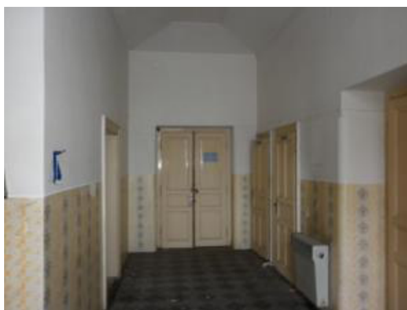
Pohled do 1. patra zájmového objektu (2.NP) 04.05. 2016
