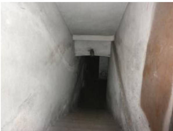
Pohled do suterénu zájmového objektu (1.PP) 04.05. 2016
