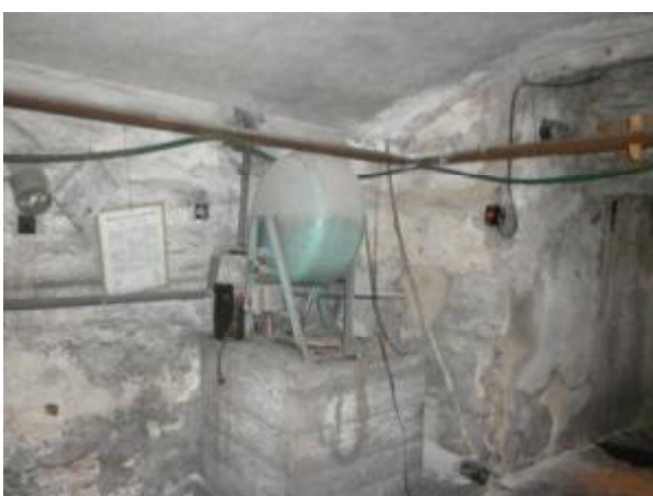
Pohled do suterénu zájmového objektu (1.PP) 04.05. 2016
