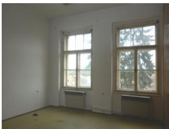
Pohled do 1. patra zájmového objektu (2.NP) 04.05. 2016
