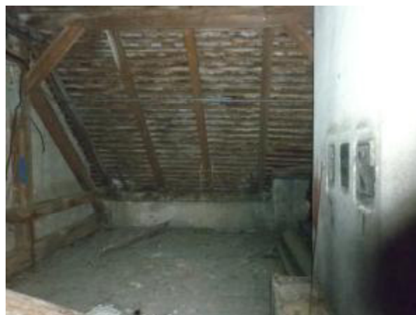
Pohled do krovového systému objektu (3.NP) 04.05. 2016
