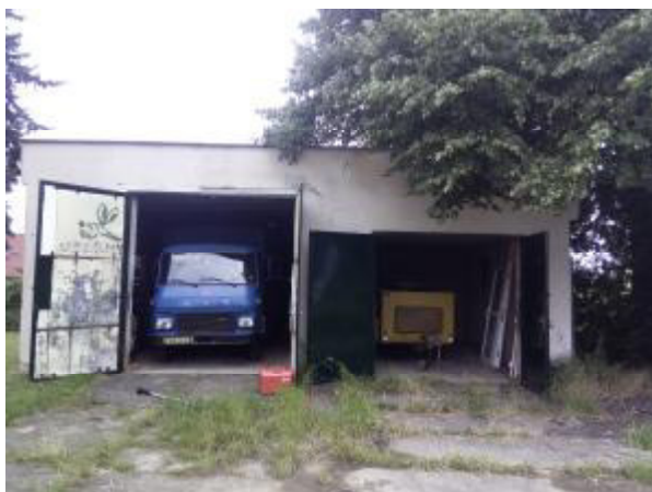
Pohled na objekt „Garáž“ od západu 21.06. 2016
