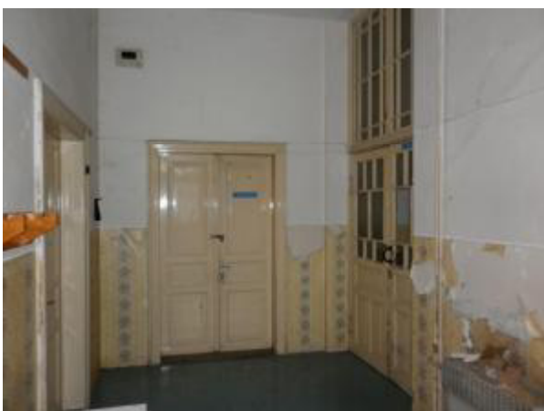
Pohled do přízemí zájmového objektu (1.NP) 04.05. 2016
