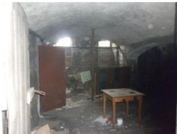
Pohled do suterénu zájmového objektu (1.PP) 04.05. 2016
