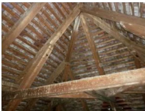
Pohled do krovového systému objektu (3.NP) 04.05. 2016
