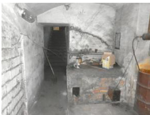
Pohled do suterénu zájmového objektu (1.PP) 04.05. 2016
