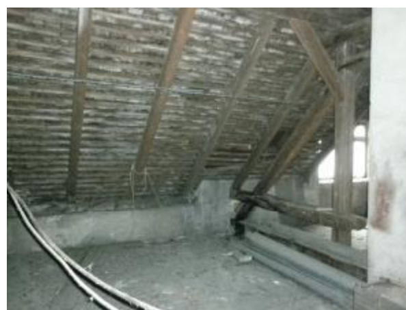
Pohled do krovového systému objektu (3.NP) 04.05. 2016
