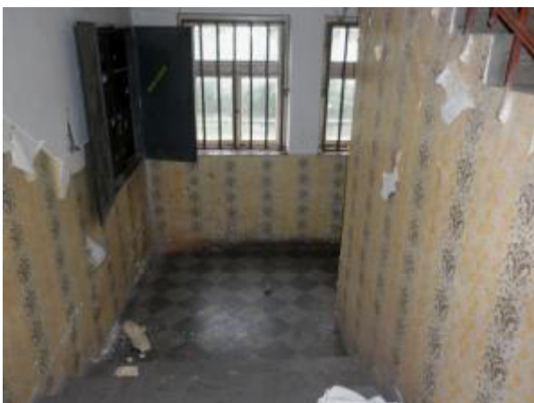
Pohled do 1. patra zájmového objektu (2.NP) 04.05. 2016
