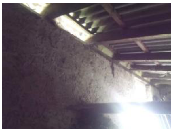
Pohled do přízemí (1.NP) objektu „Sklad“ 21.06. 2016
