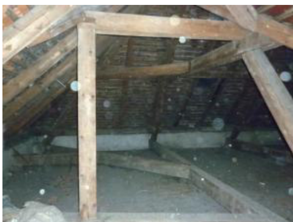
Pohled do krovového systému objektu (3.NP) 04.05. 2016
