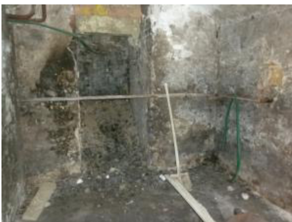
Pohled do suterénu zájmového objektu (1.PP) 04.05. 2016
