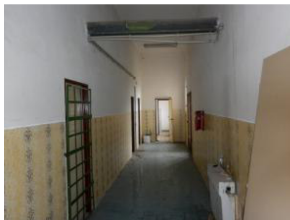
Pohled do přízemí zájmového objektu (1.NP) 04.05. 2016
