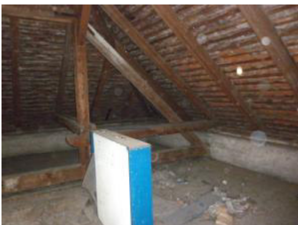
Pohled do krovového systému objektu (3.NP) 04.05. 2016
