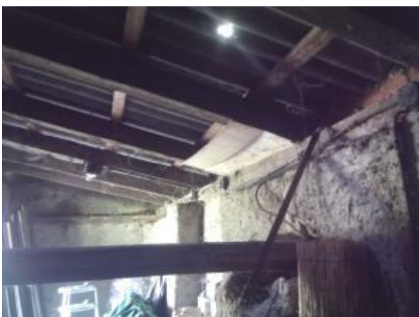
Pohled do přízemí (1.NP) objektu „Sklad“ 21.06. 2016
