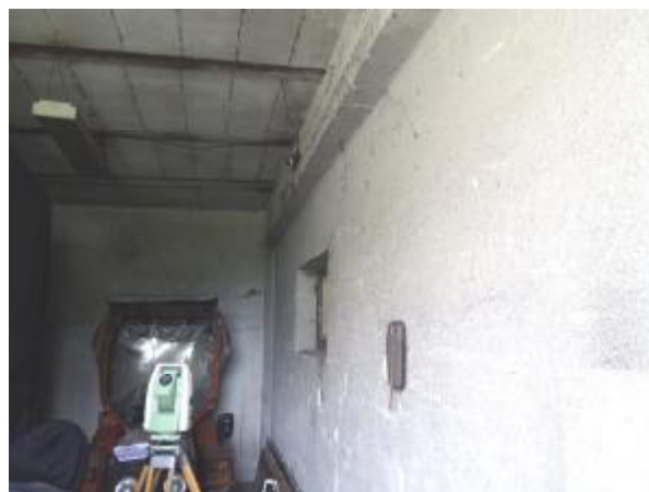
Pohled do přízemí (1.NP) objektu „Garáž“ 21.06. 2016
