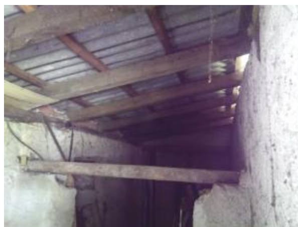
Pohled do přízemí (1.NP) objektu „Sklad“ 21.06. 2016
