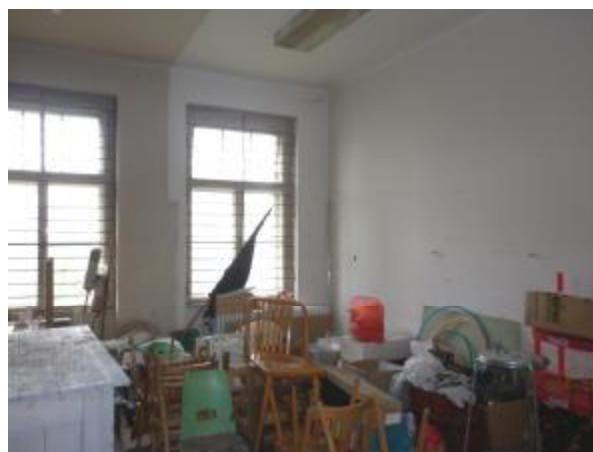
Pohled do přízemí zájmového objektu (1.NP) 04.05. 2016
