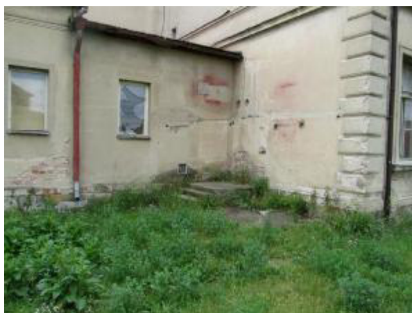
Pohled na „JV přístavbu“ obj. „Obecná škola“ 11.05. 2016
