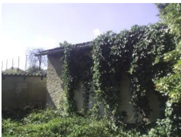
Pohled na objekt „Sklad“ od východu 21.06. 2016
