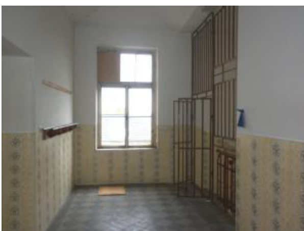
Pohled do 1. patra zájmového objektu (2.NP) 04.05. 2016
