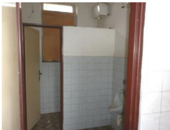
Pohled do přízemí zájmového objektu (1.NP) 04.05. 2016
