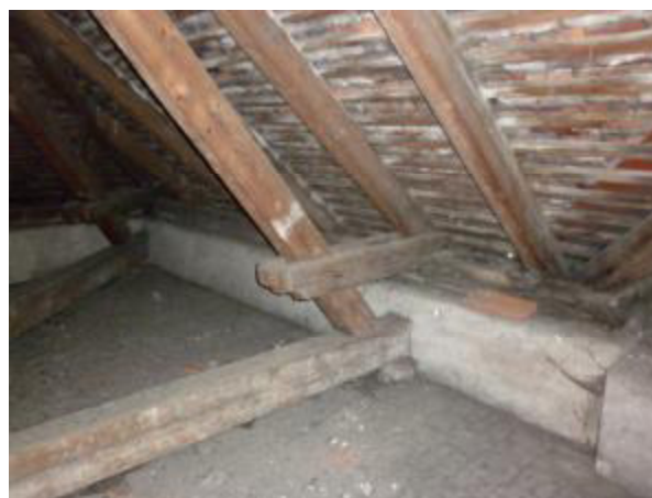
Pohled do krovového systému objektu (3.NP) 04.05. 2016
