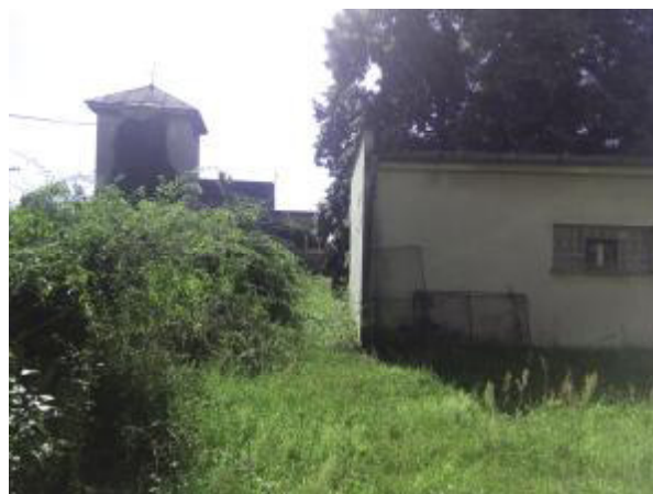
Pohled na objekt „Garáž“ od severu 21.06. 2016
