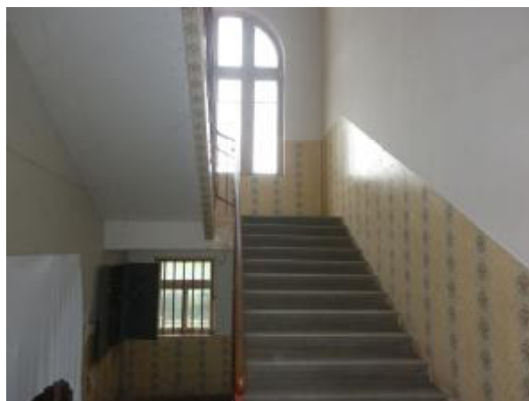
Pohled do přízemí zájmového objektu (1.NP) 04.05. 2016
