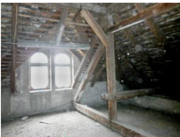
Pohled do krovového systému objektu (3.NP) 04.05. 2016
