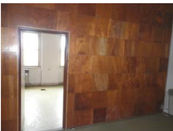
Pohled do 1. patra zájmového objektu (2.NP) 04.05. 2016
