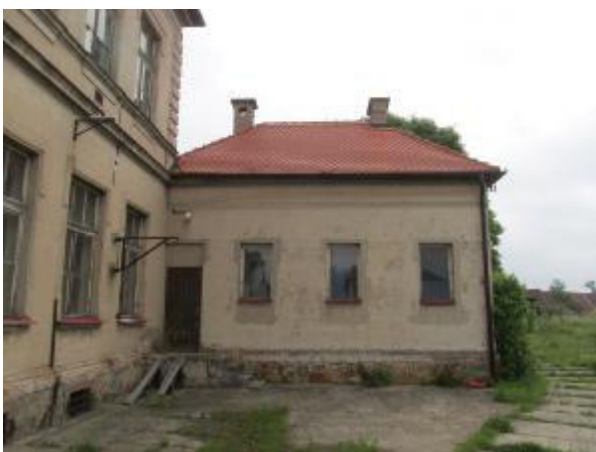
Pohled na „Jižní trakt“ objektu „Obecná škola“ 01.06. 2016
