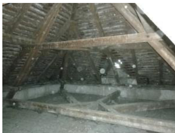
Pohled do krovového systému objektu (3.NP) 04.05. 2016
