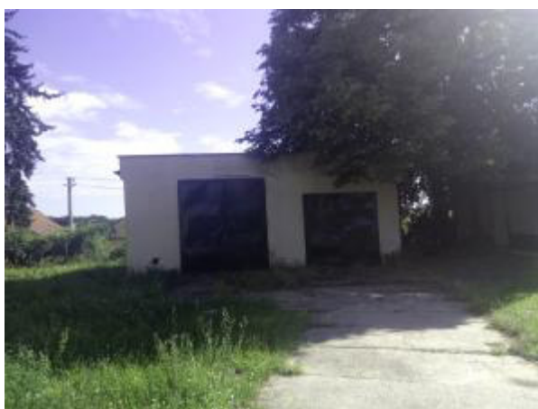
Pohled do prostoru zájmového areálu 30.07. 2016
