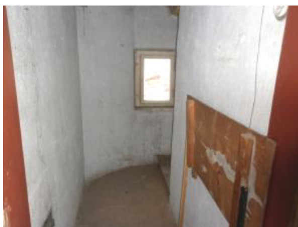
Pohled do 1. patra zájmového objektu (2.NP) 04.05. 2016
