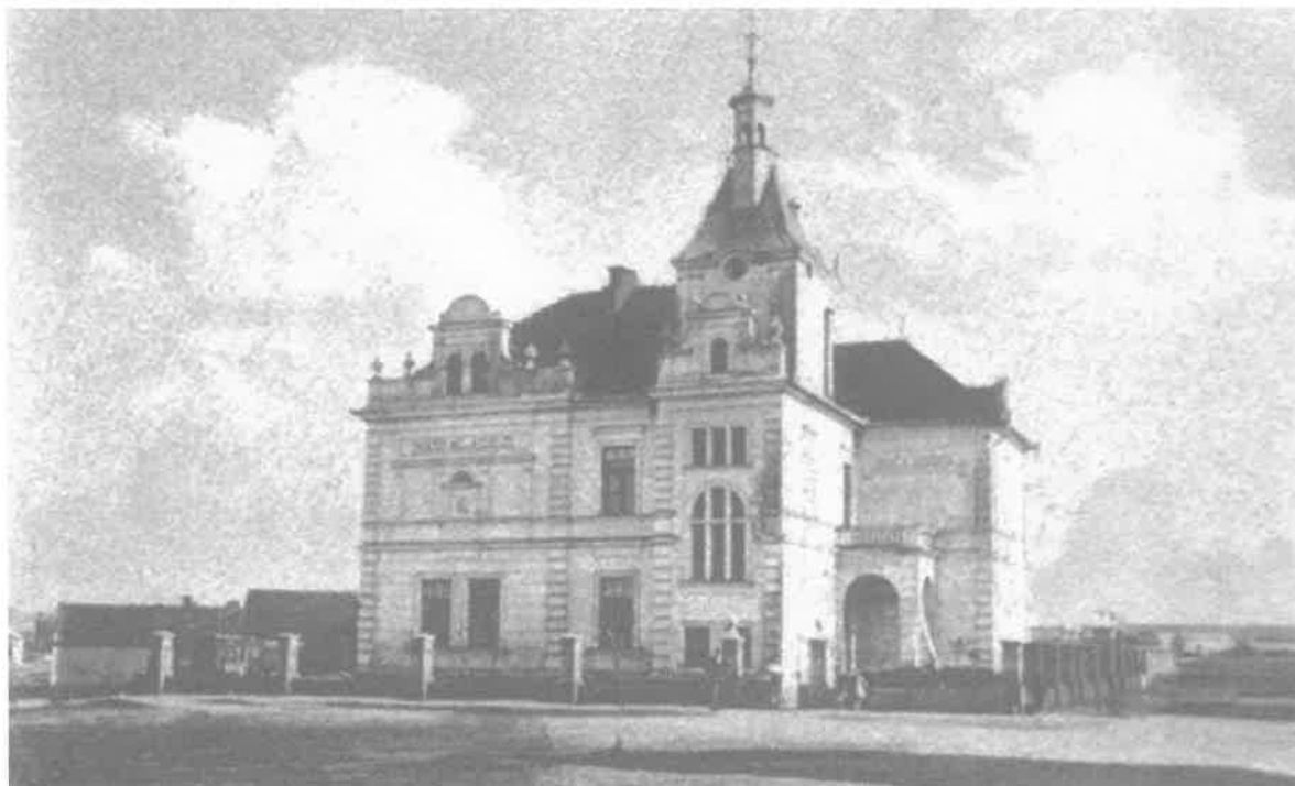
Obr. 5 Historický snímek zachycující školu po dostavbě (cca r. 1909) při pohledu od severu 10
