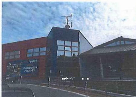
Objekt čištění: Aquapark Beroun
