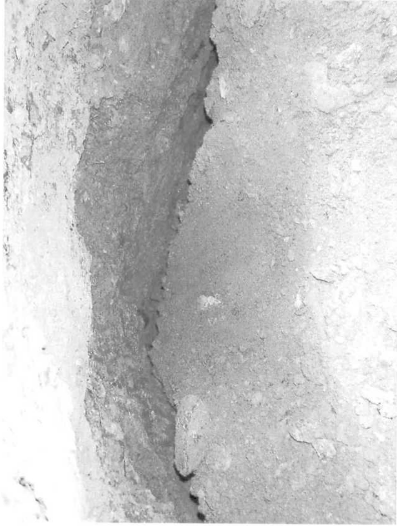
Obr. 03 Detail propadu ve dně výkopu.
