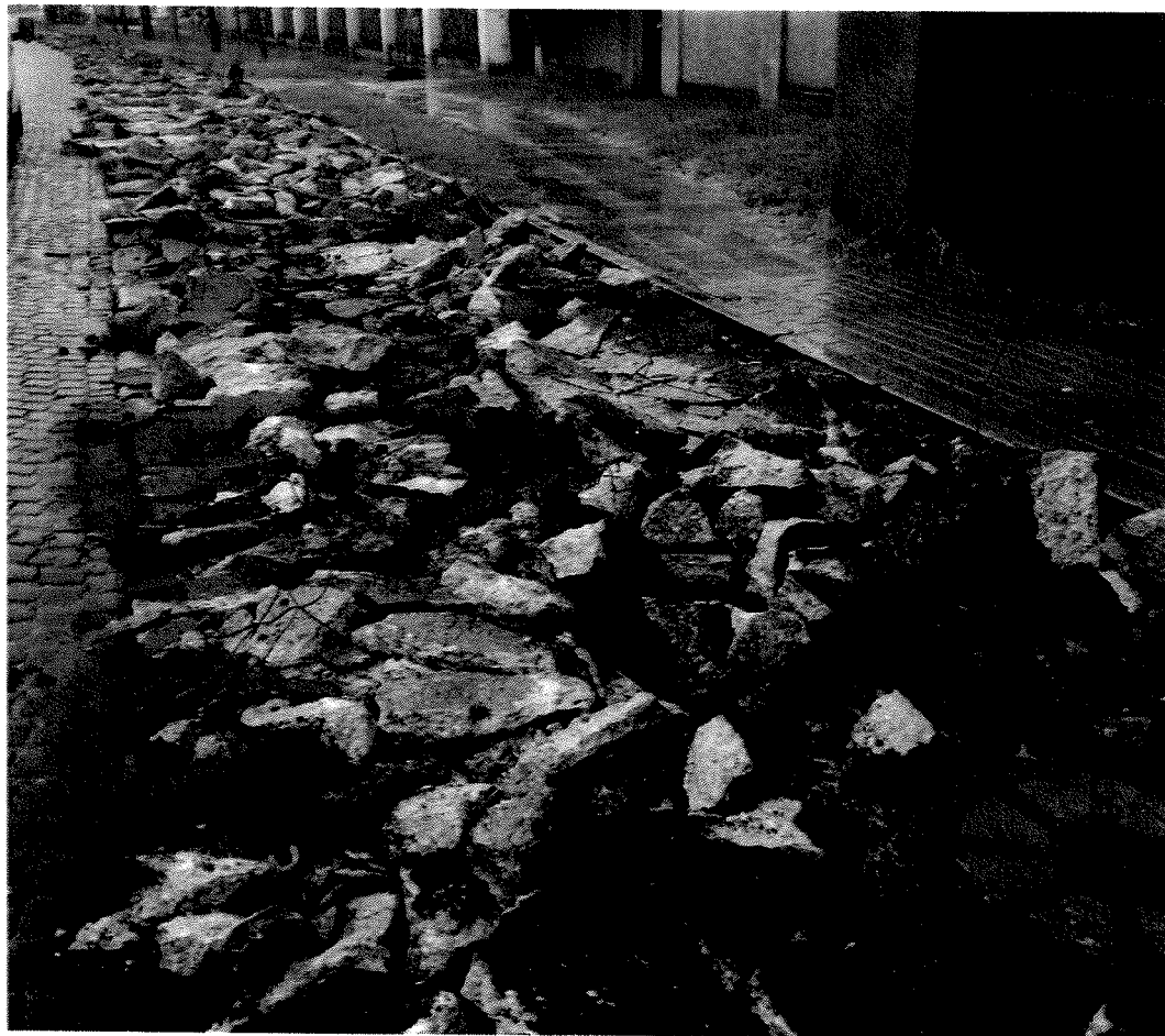
Vybouraná vrstva ŽB konstrukce SO 001.1 a 2
