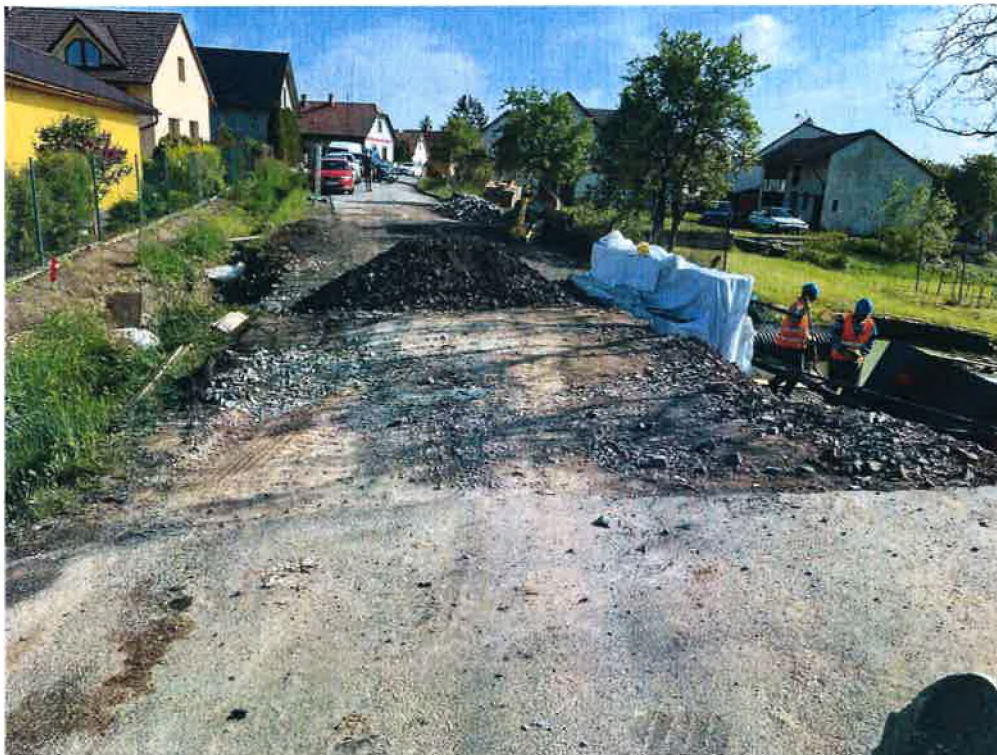
Stav prací k 20.5.2021 (9:00h)
