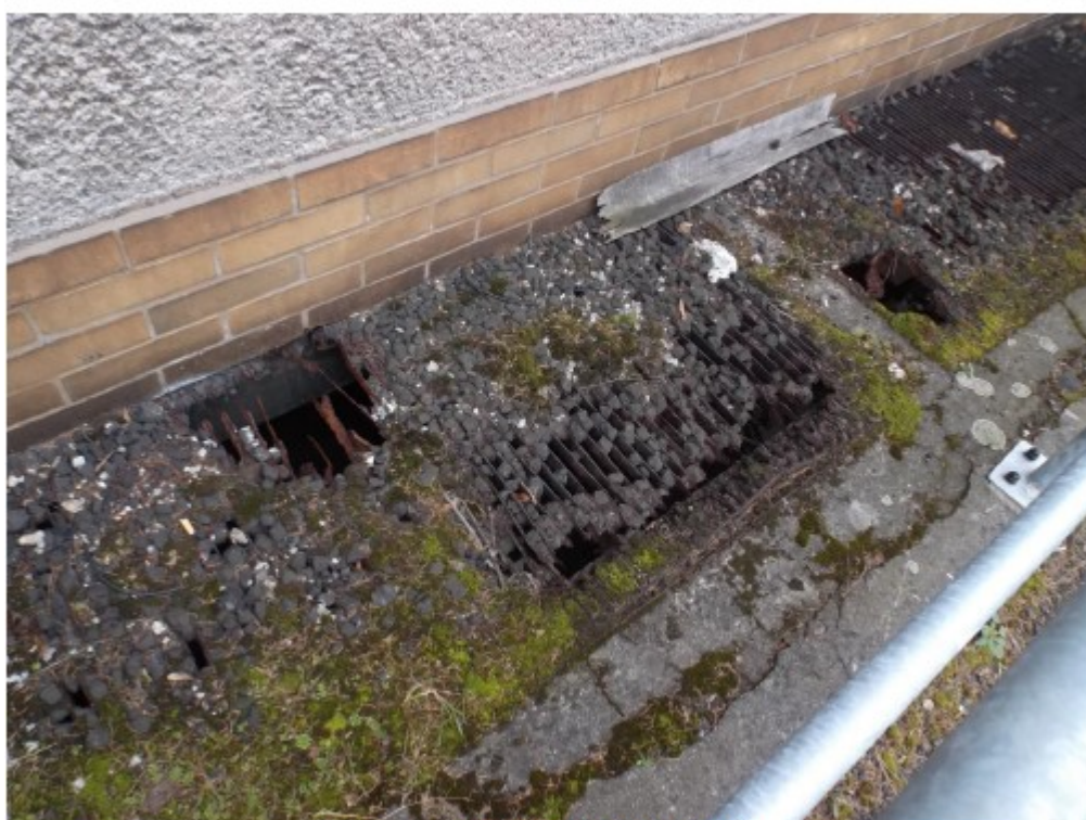
Obr. č.4 – Stávající střešní drenáž
