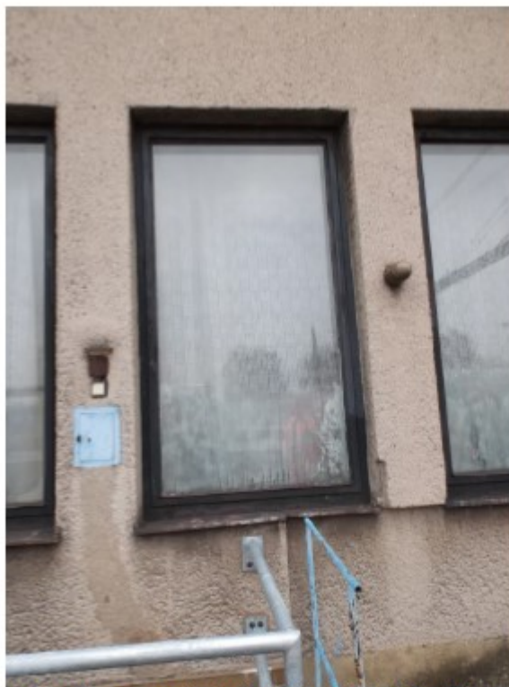
Obr. č.3 – Detailní stávajícího dřevěného okna
