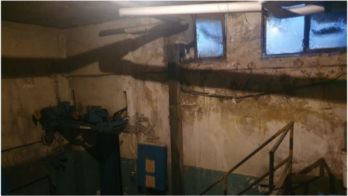
Obr. č. 7 – Sklepní prostory
