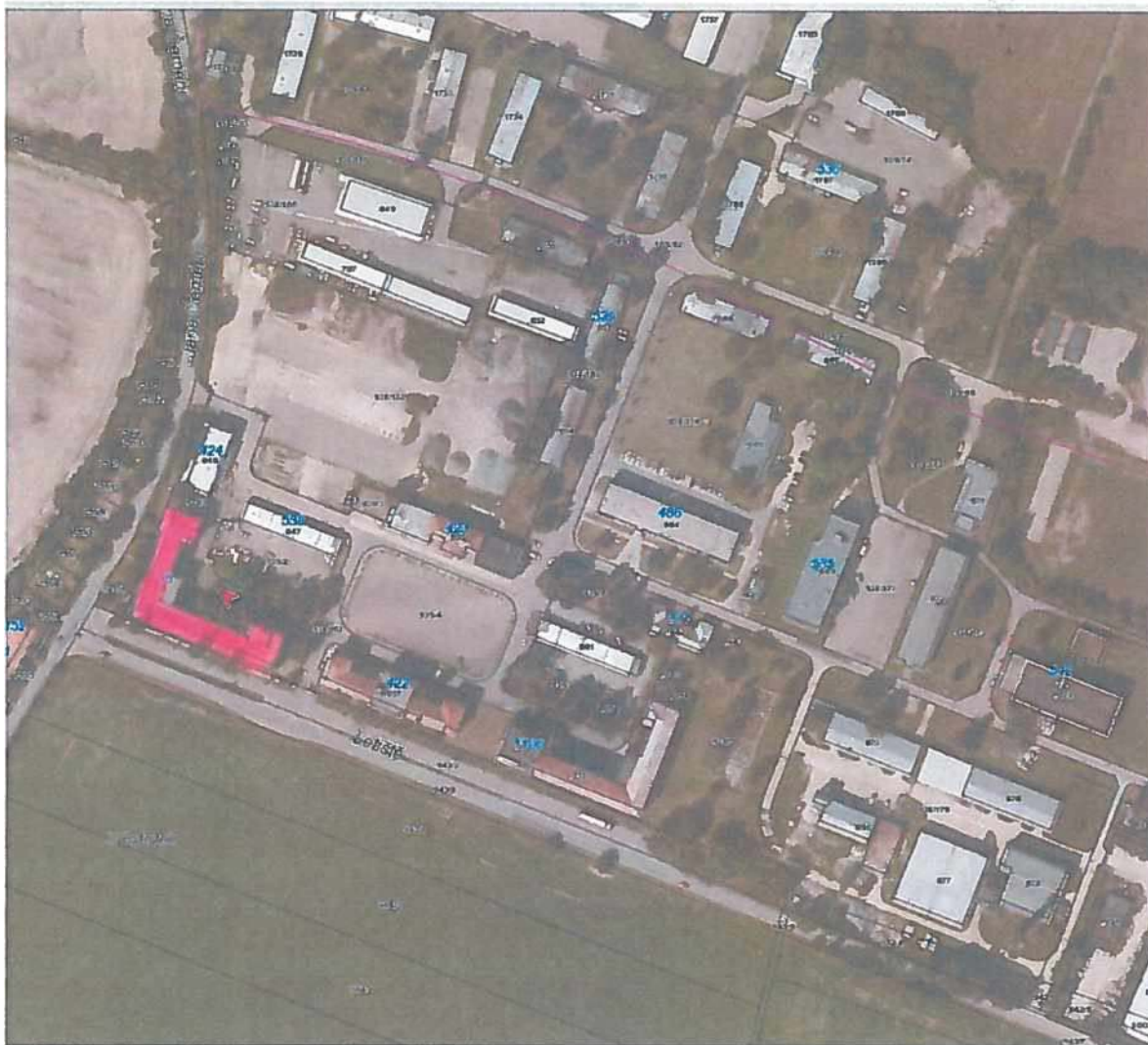
Příloha č. 1: budova čp. 98, na stp. č. 108, k. ú. Věkoše
