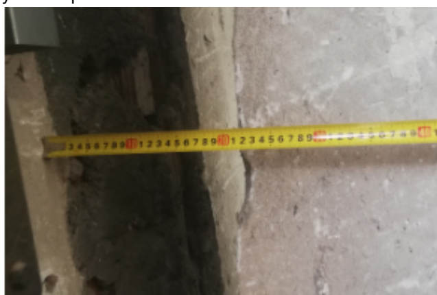
7) Velikost trhlín – velikost vybočení (vlevo), šířka trhlíny (vpravo)
