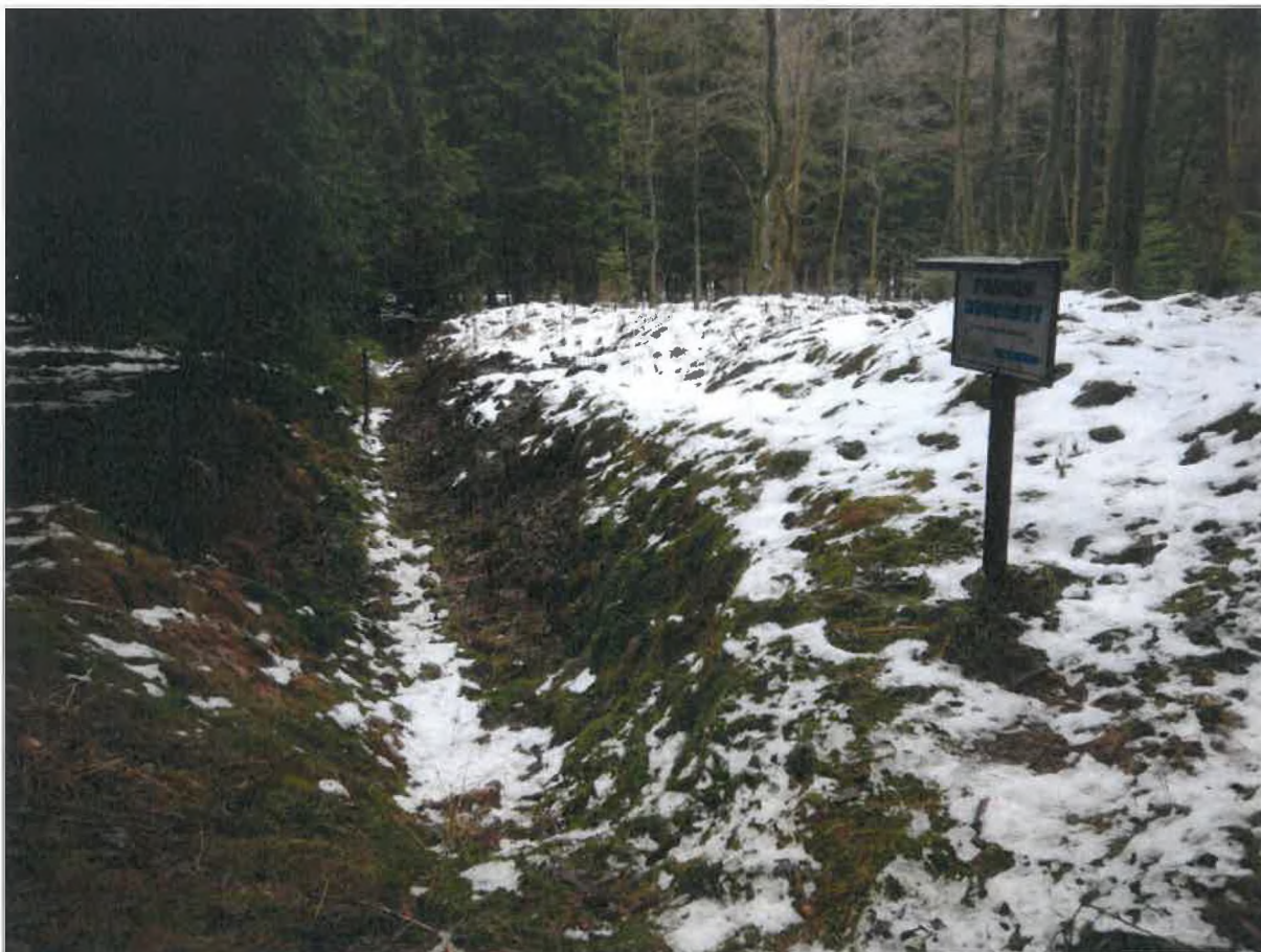
Obr. : Horní konec příkopu 2. Vpravo od příkopu leží deponie zeminy vybagrovaná z příkopu. Je plánováno vrátit materiál zpět na původní místo, zůstane pouze mělká odtoková deprese (z 49.6356564N, 15.8685611E k S).
