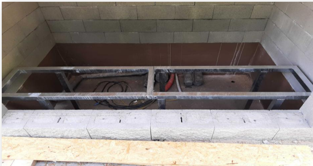
Příloha č. 1 k: ZL01 - Výroba, dodávka montáž Ocelové konstrukce pod čerpadla atrakcí a úprava vrat Fotodokumentace
