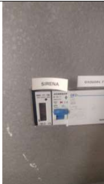
Obr. ES.23-8 – rozvaděč NN doplněný jističem 10A/B a podružným elektroměrem přívodu
