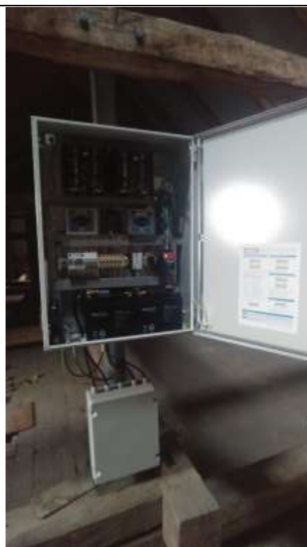
Obr. ES.23-6 – Obr. ES.23-5 – otevřený rozvaděč sirény
