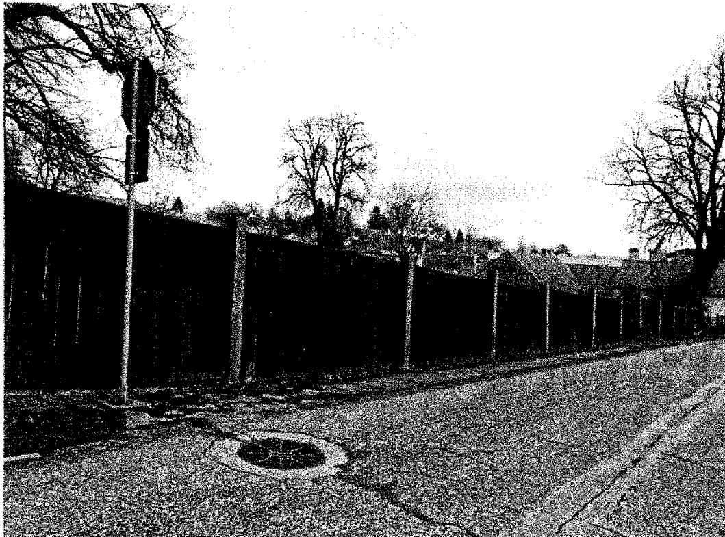
Volejbalové hřiště – oplocení, ulice Ferd. Čermáka
