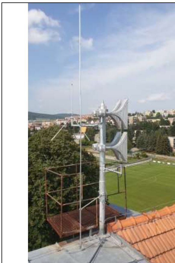
Obr. ESN.15-1 – detail stožáru, 6 ozvučnic na novém stožáru, antény VIS a JSVV na výložníku, oddálený jímáč hromosvodu
