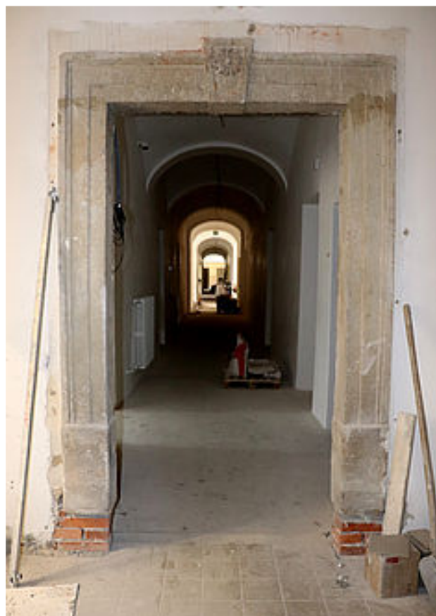
Změna 139 – Sanace pískovcového portálu v chodbě 117a – vložení pískovcových bloků
