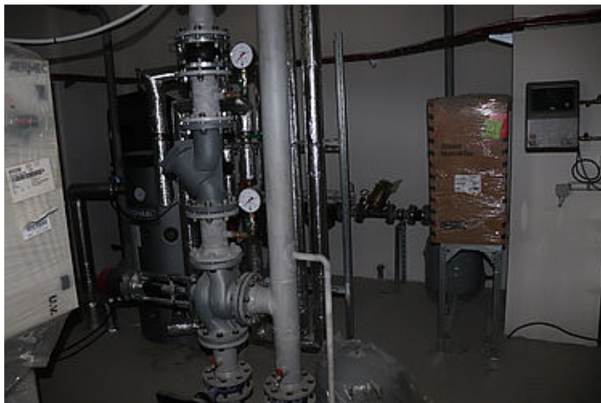
Změna 128 – Doplnění armatur ve strojovně VZT (3. NP)
