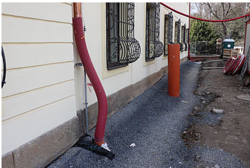
Změna 121 – Odpočet obrubníků a Změna 138 – Narovnění dlažeb a chodníků – jiné provedení
