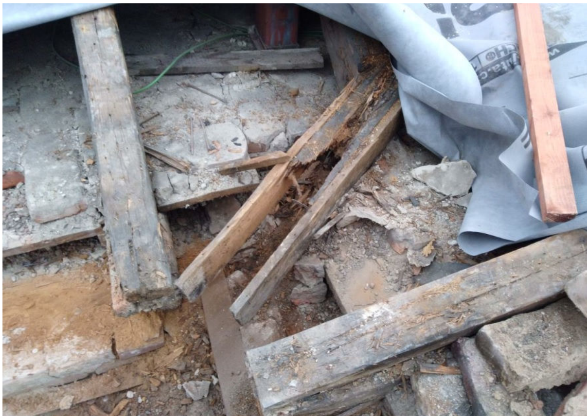
Změna č. 108 – Krov dvoupodlažní přístavby – vyhnílá pozednice krovu
