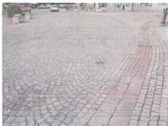
Plošná deformace, umístění sondy S 4
