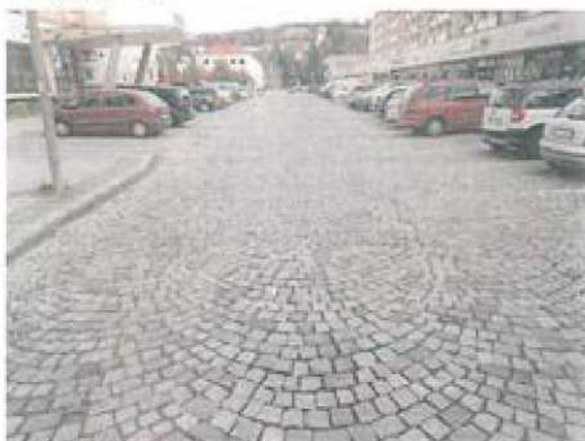
Plošná deformace
