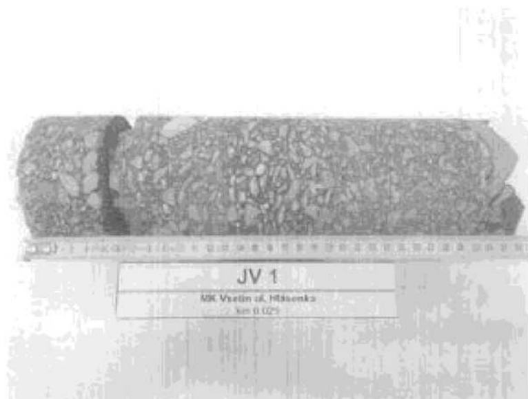
Foto č. 1 – Detail vývrtu JV 1
