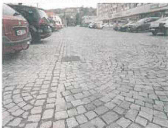
Plošná deformace, nerovnost v místě vpusti
