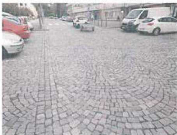
Plošná deformace
