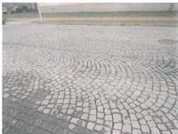
Plošná deformace, umístění sondy S 3
