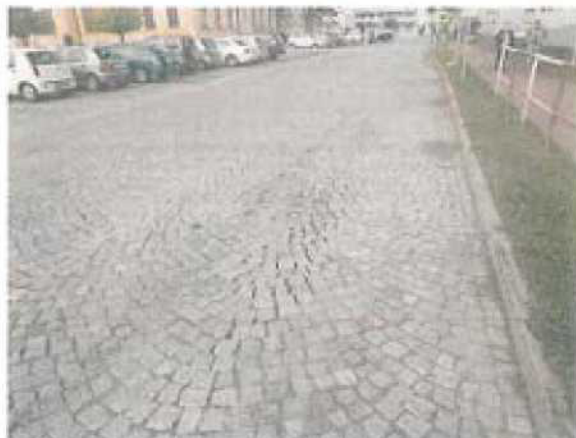
Plošná deformace, vyjeté koleje, poklesy
