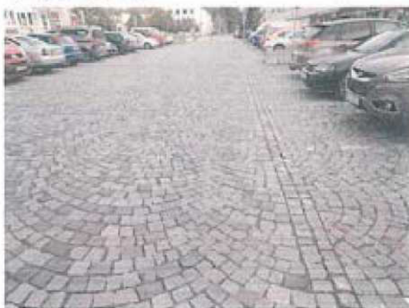
Plošná deformace
