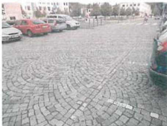
Plošná deformace, umístění sondy S 2
