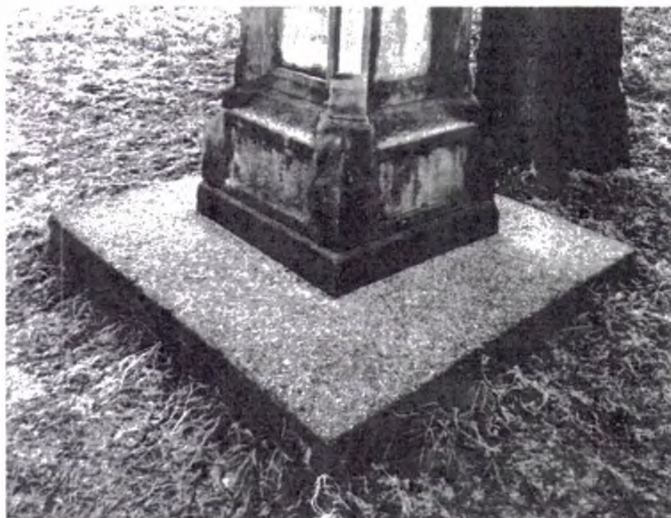
Současný stav - detail zabetonované kamenné základny.
