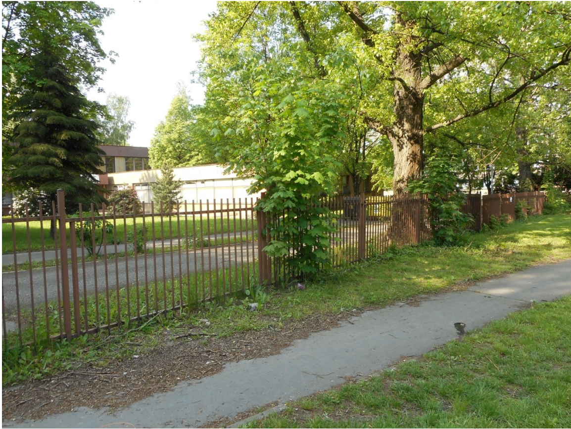
Nátěr a oprava oplocení kolem objektu Galaxie na ulici Kašparově čp. 2978 v Karviné-Hranicích
