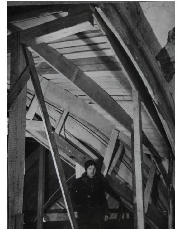
Bednění s ramenáty
