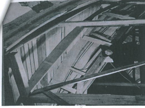
Bednění s ramenáty
